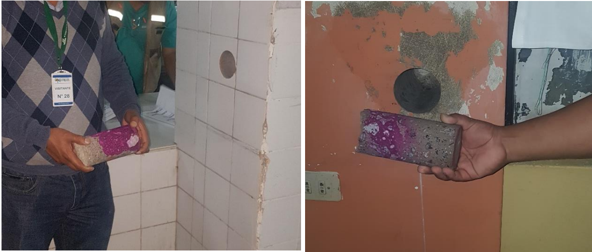
Figura 4, 4.7 cm de carbonatacion, fuente: propia Figura 5, 5.2 cm de carbonatacion, fuente: propia
