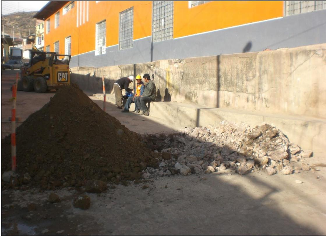
**Excavación de calicata c-2, lado posterior del edificio, nótese el material en estado húmedo.**
