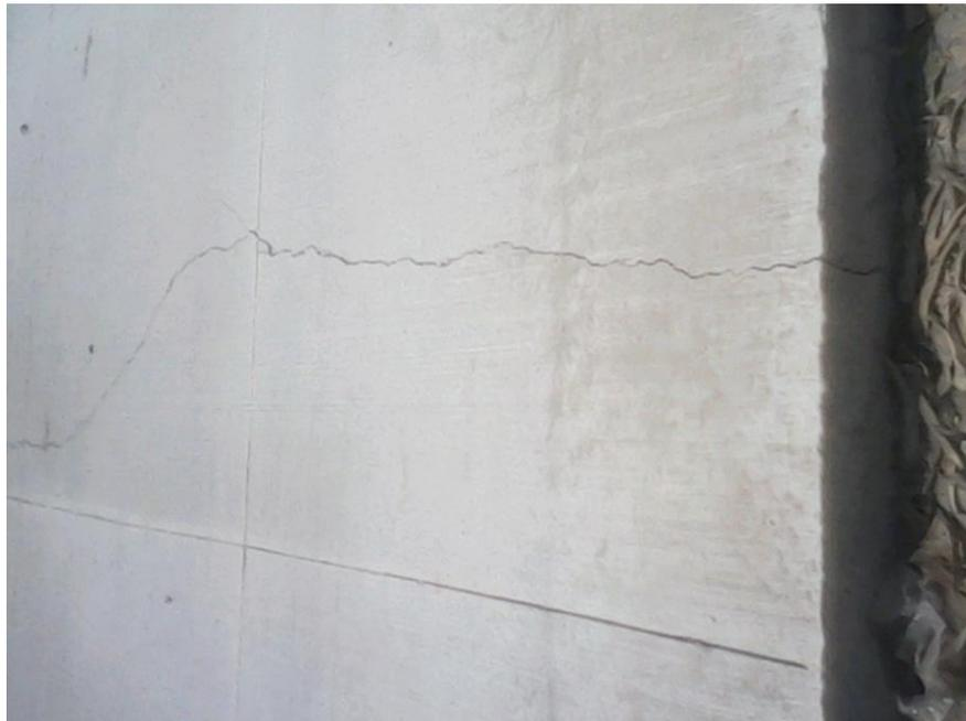
**Figura 2.** Falla en la vía pavimentada con concreto.
