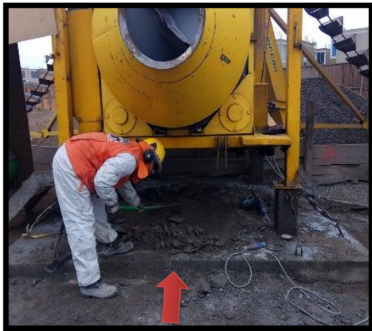
DESCIPCIÓN: Planta de concreto
