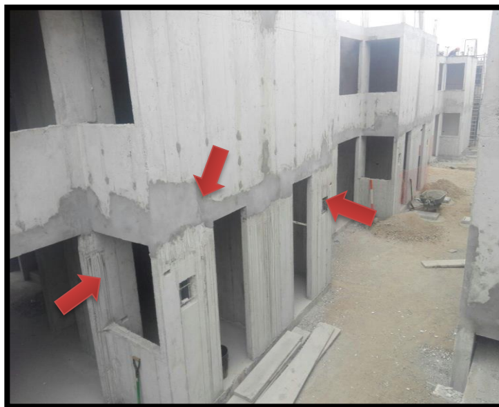
FIGURA 26: Reparación de desplome de placa -
