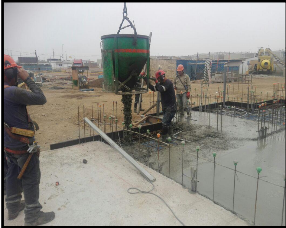
FIGURA 13: Vaciado de platea de cimentación
