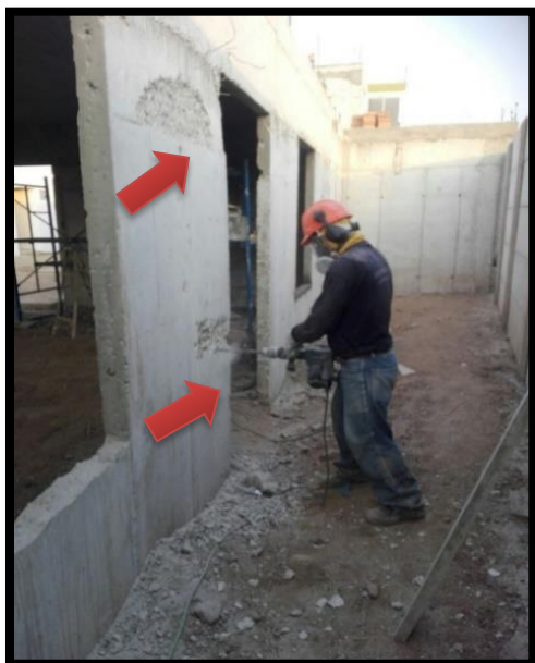
FIGURA 27: Reparación de desplome de placa -
