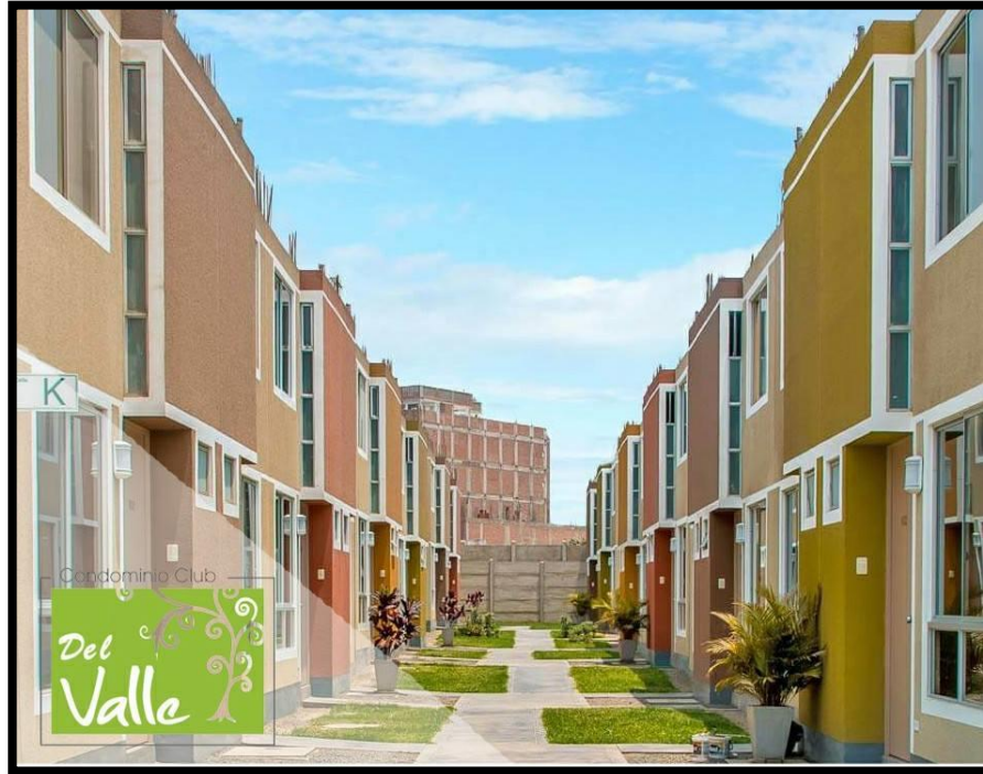
FIGURA 12: Primera etapa – condominio residencial club del valle
