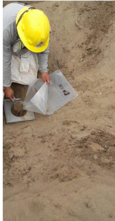
Foto N° 9: Calicata CA-CO16-106. Ensayo de densidad por el método del cono de arena.
