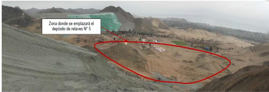
Foto N° 1: Vista panorámica del sector donde se emplazará el depósito de relaves N° 5.
