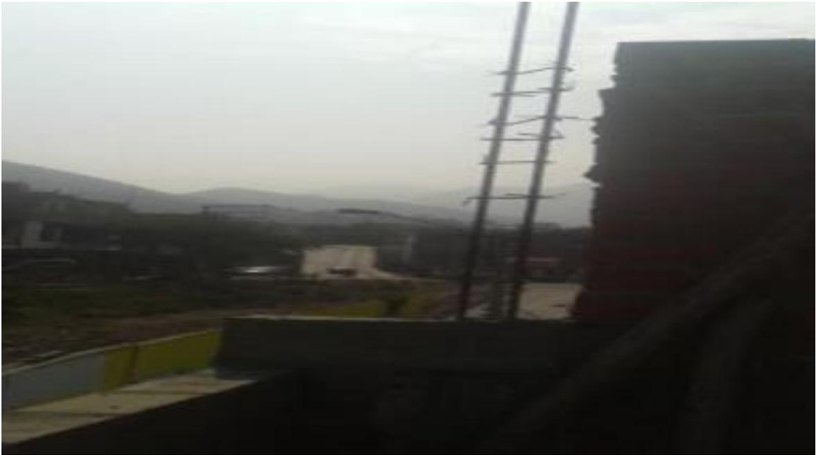
**Figura N° 2:** En esta figura se aprecia que la columna no hace ningún amarre con la pared porque se encuentra alejada.
