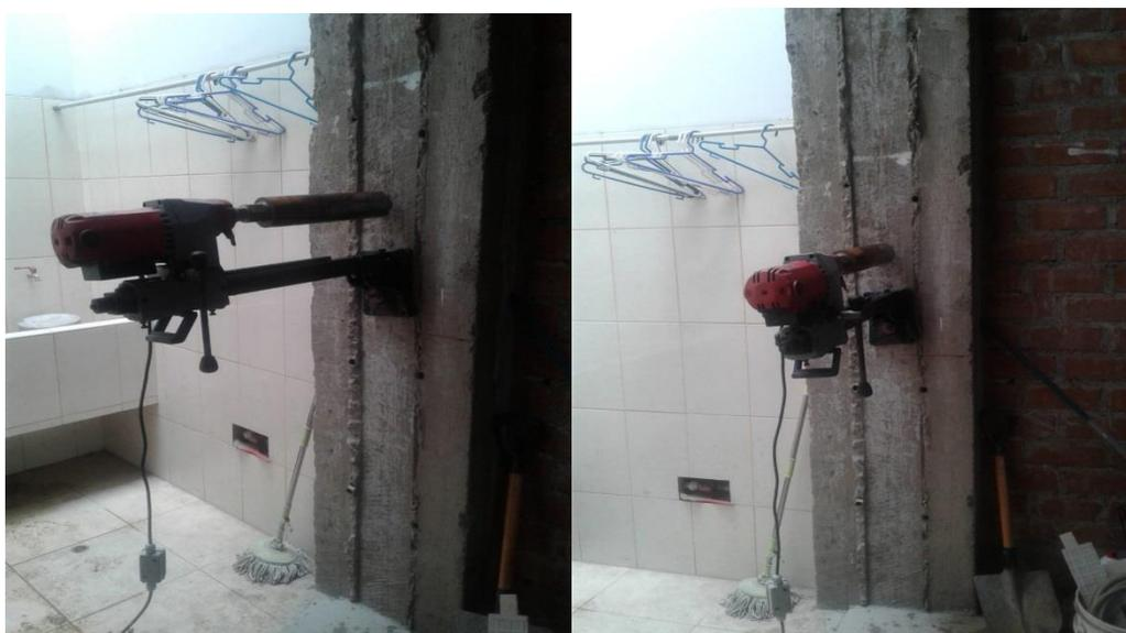
**Figura N° 1:** extracción de diamantina
