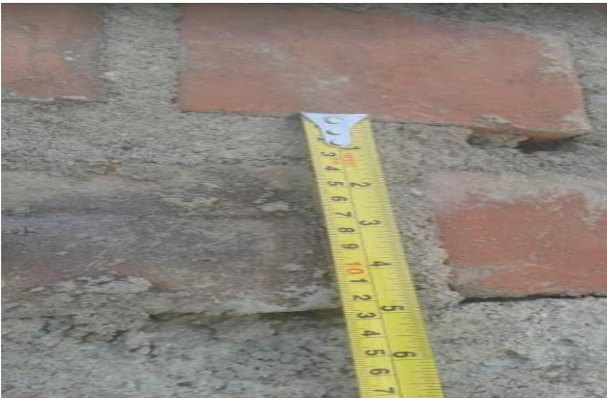
**Figura N° 3:** En la figura se puede observar la deficiencia que tiene la junta de albañilería.
