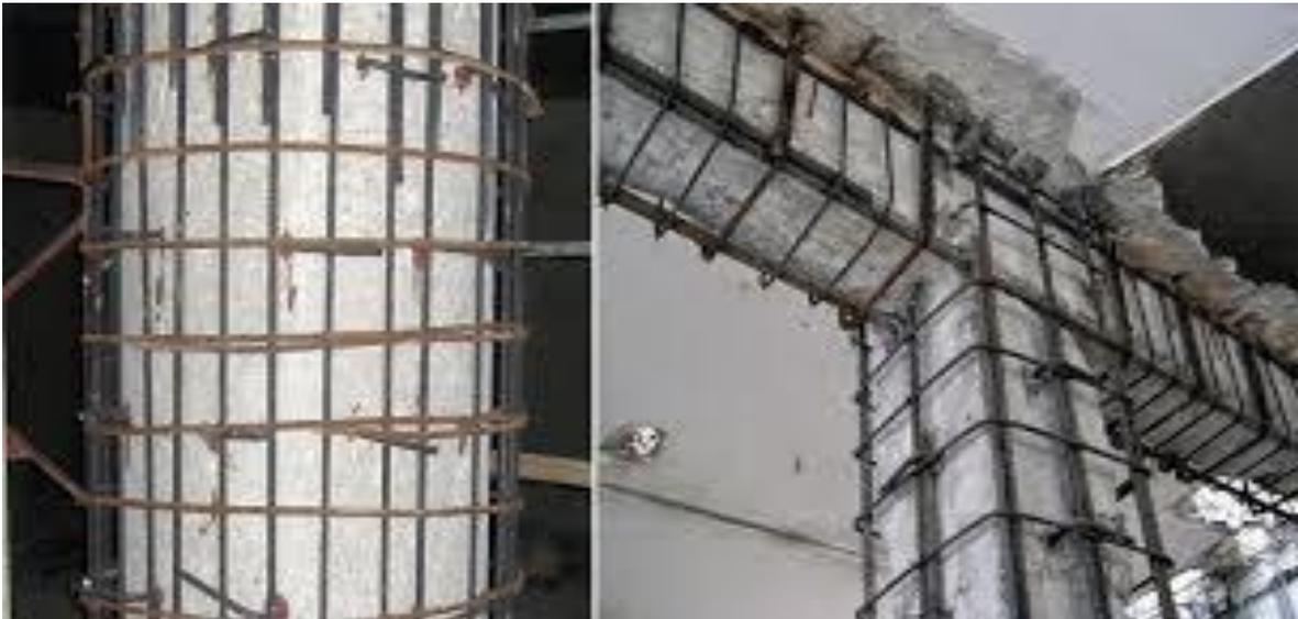
Figura 5. Encamisado de viga y columna. Fuente: google
