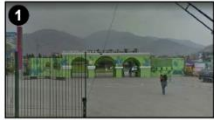
Parque Zonal Huiracocha con un área de 234.764 m 2 , administrado por el Servicio de Parques de Lima -SERPAR.
