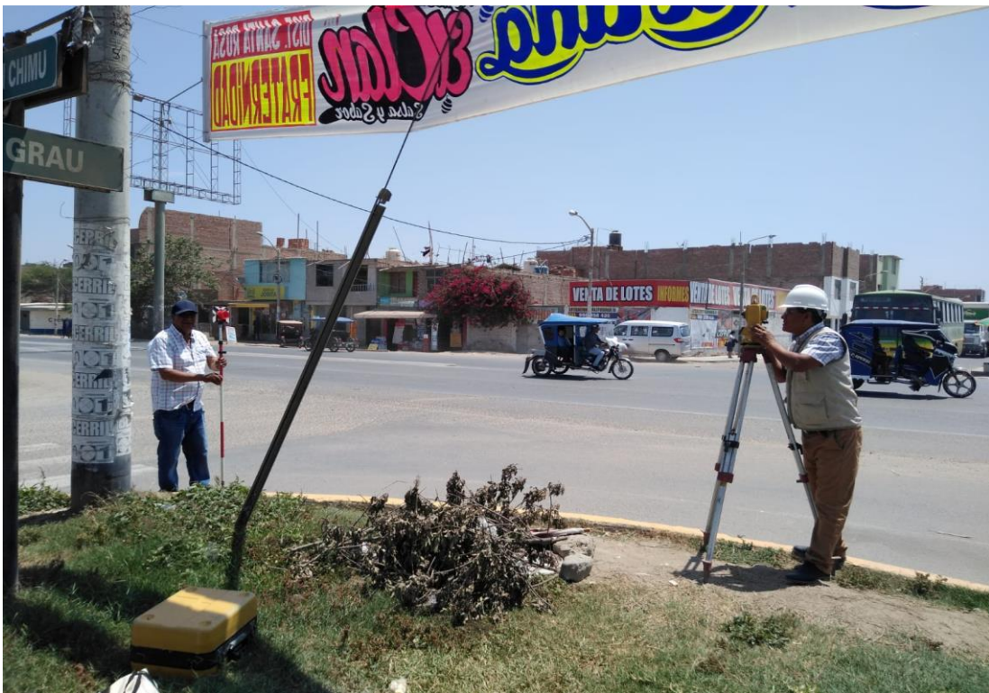
Toma Topográfica – Definición de la Poligonal
