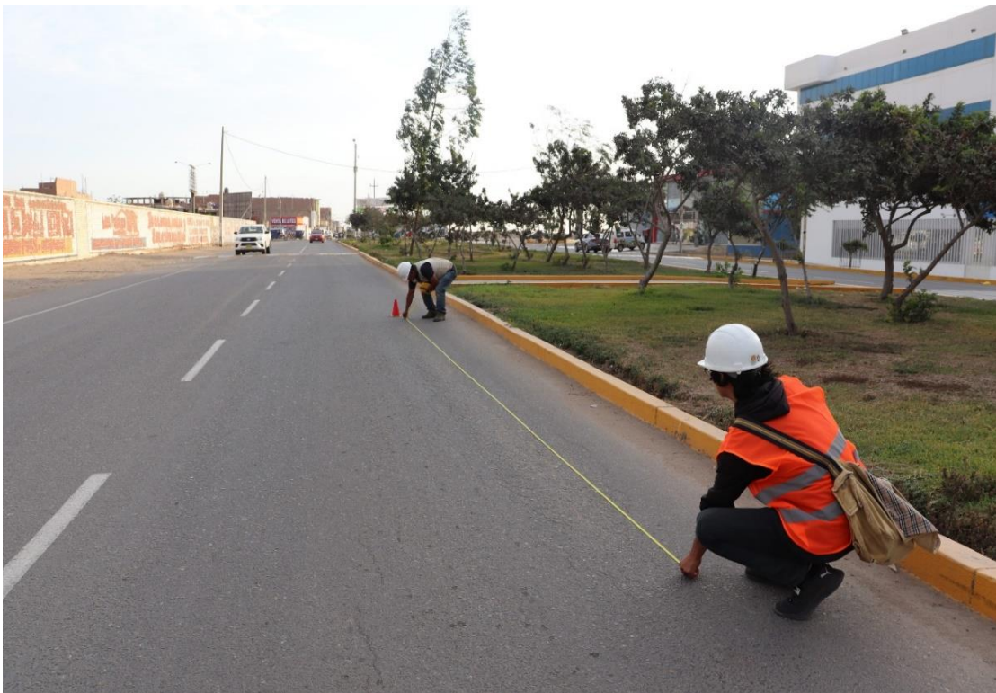
Medición del Ahuellamiento en el pavimento.
