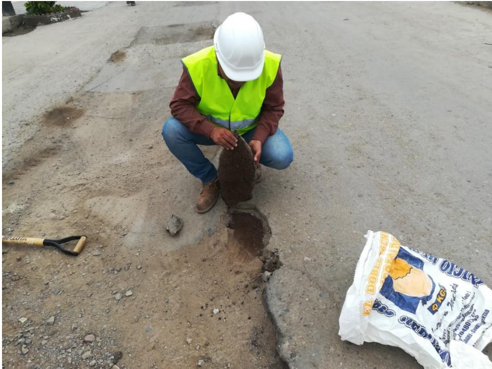
Calicata8 - Av. San Martin.
