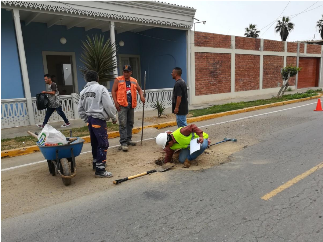
Calicata 5 - Av. San Martin.
