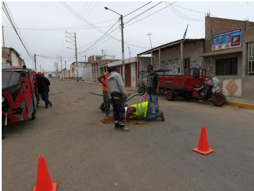
Calicata 7 - Av. San Martin.
