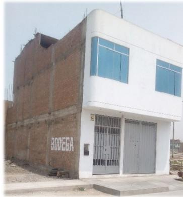
**Figura 6.** *Viviendas de albañilería confinada construidas con ladrillo pandereta*
