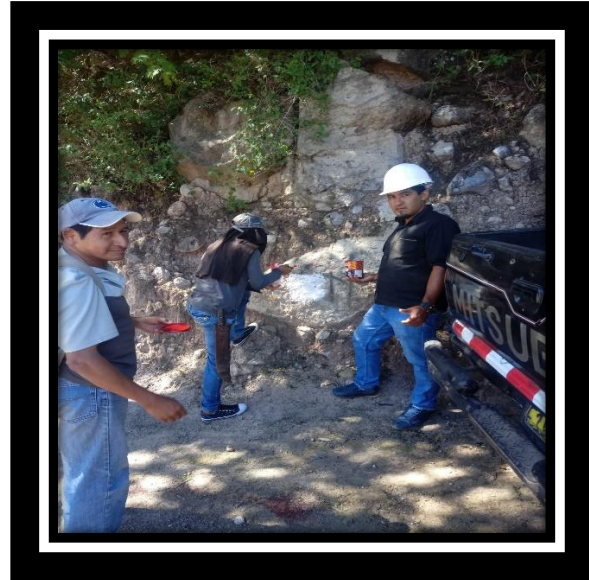
Punto inicial 0+0000 puente las verdes
