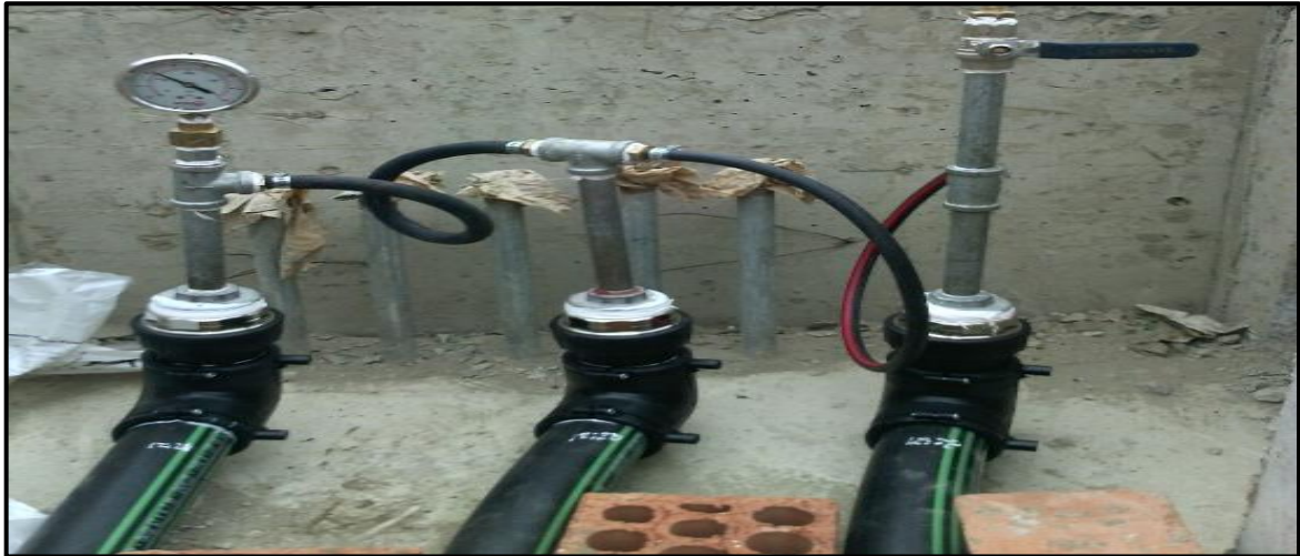
Figura 18. Prueba de hermeticidad
