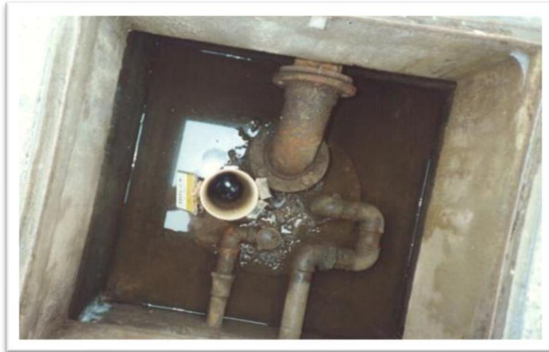
Figura 5. (Manhole bomba antes)
