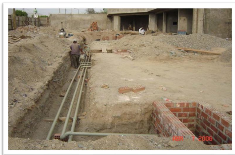
Figura 8. (Recorrido tanque a dispensador)
