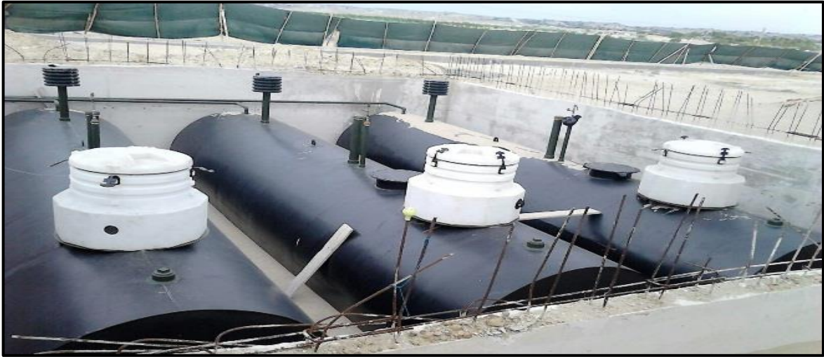
Figura 16. Estación Stiven de Piura
