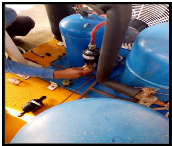
Figura 14. Instalación de filtro, visor liquido
