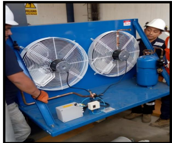
Figura 15. Instalacion nueva unidad
