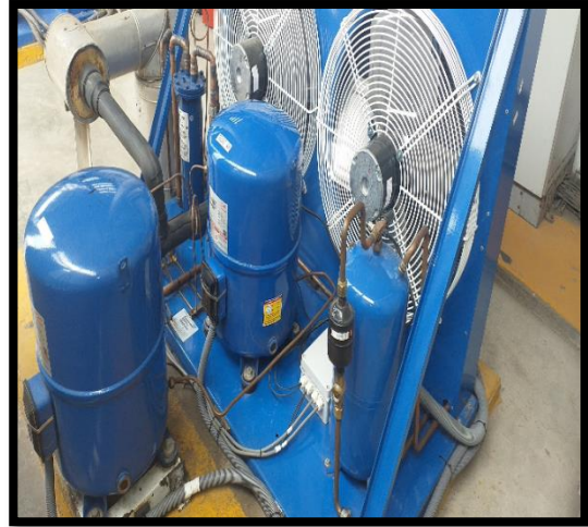
Figura 19. Nueva unidad instalada
