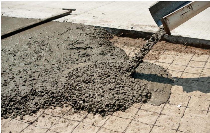
Figura 72 Material para construcción
