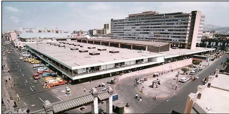
Figura 24 Fachada lateral Izquierda - Mercado Central de Lima
