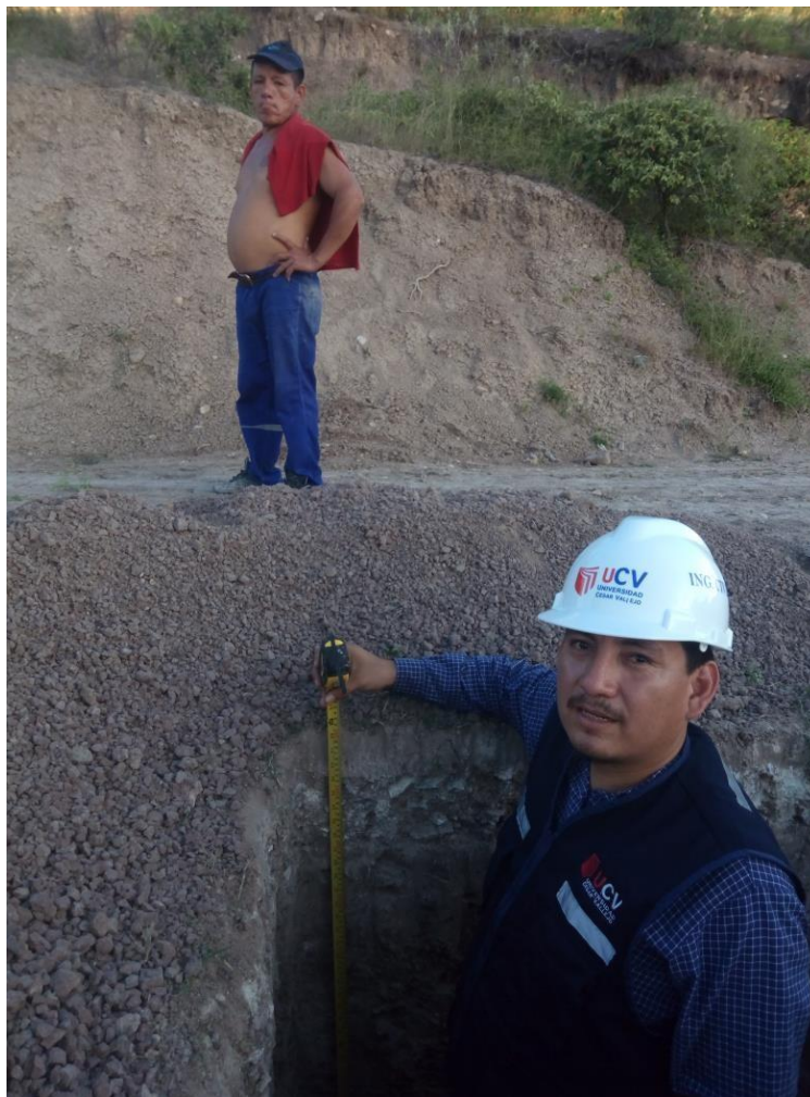
Haciendo la medición de la profundidad de la calicata
