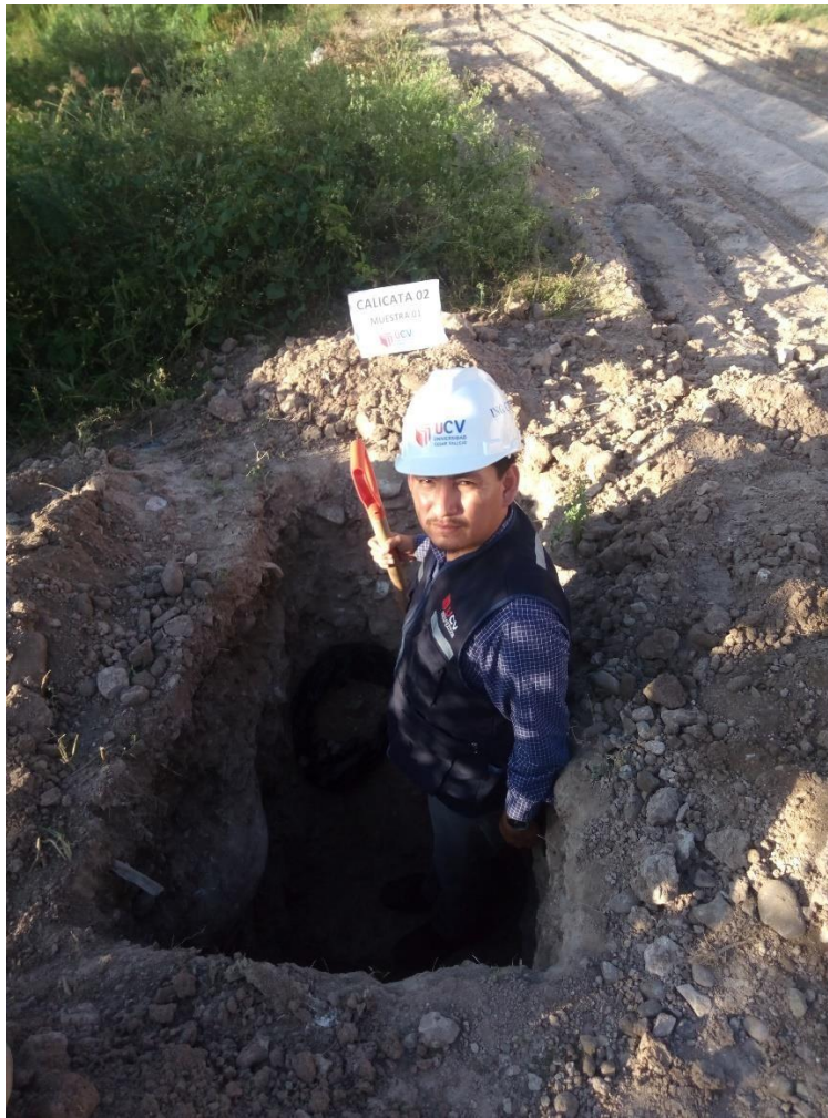
Recogiendo las muestras de la calicata N° 2
