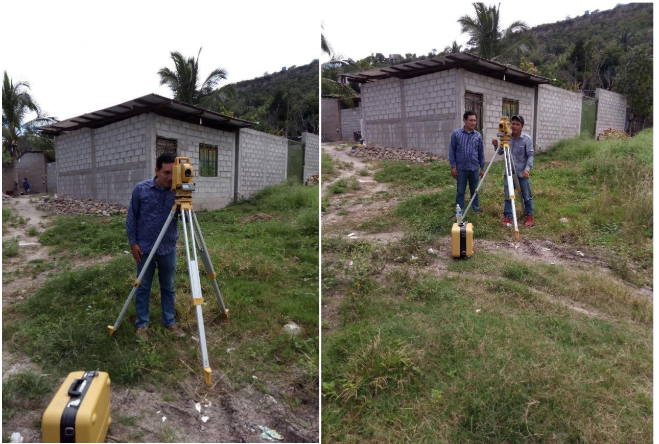
Topografía esquina ultima cuadra del jr Piura
