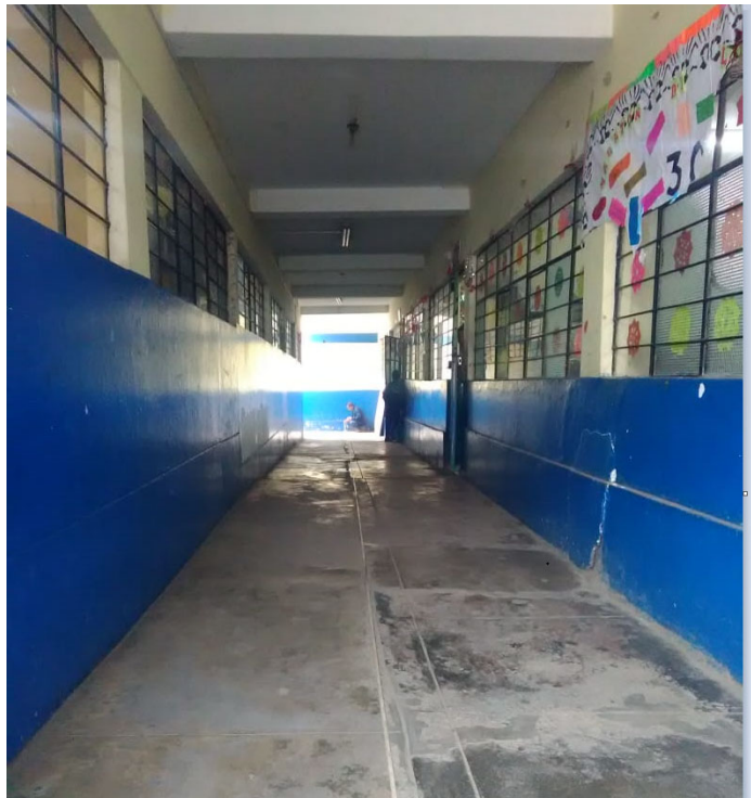
Fotografía N° 6: levantamiento toma de medidas en el 1° piso del pabellón B del colegio Antonia Moreno de Cáceres
