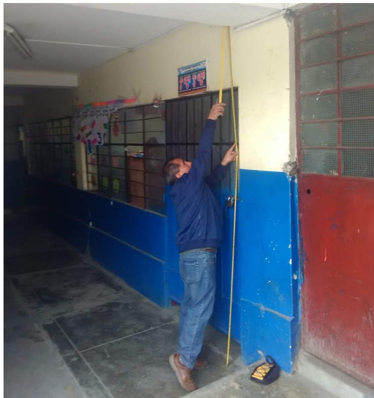
Fotografía N° 4: levantamiento toma de medidas en el 1° piso del pabellón B del colegio Antonia Moreno de Cáceres
