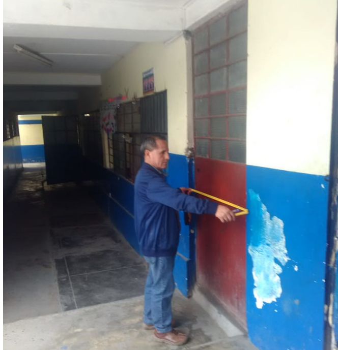
Fotografía N° 5: levantamiento toma de medidas en el 1° piso del pabellón B del colegio Antonia Moreno de Cáceres
