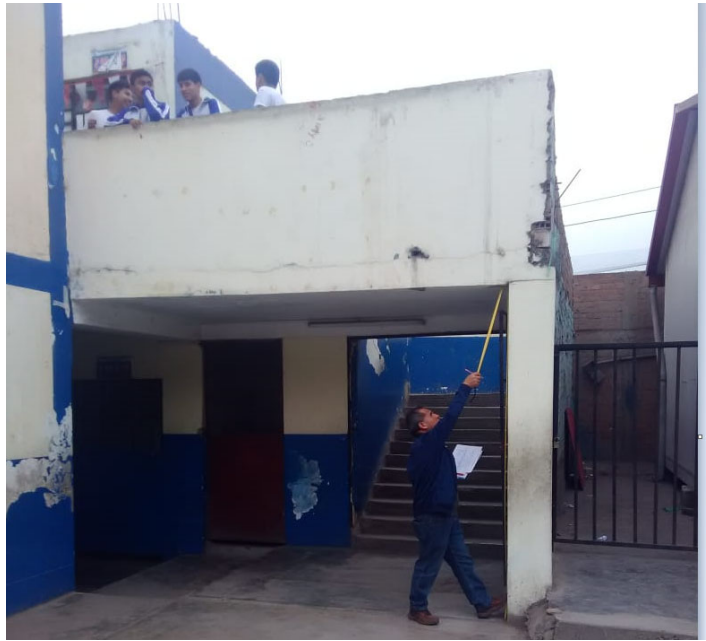
Fotografía N° 3: levantamiento toma de medidas en el 1° piso del pabellón B del colegio Antonia Moreno de Cáceres
