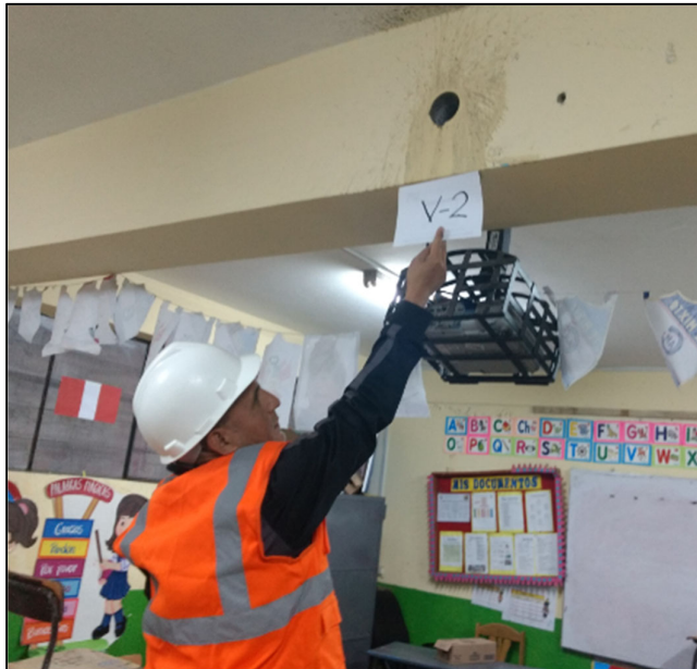
Fotografía N° 21: perforación para la obtención del testigo diamantino V-2 en la viga del 1° piso del pabellón B de la I.E. Antonia Moreno de Cáceres
