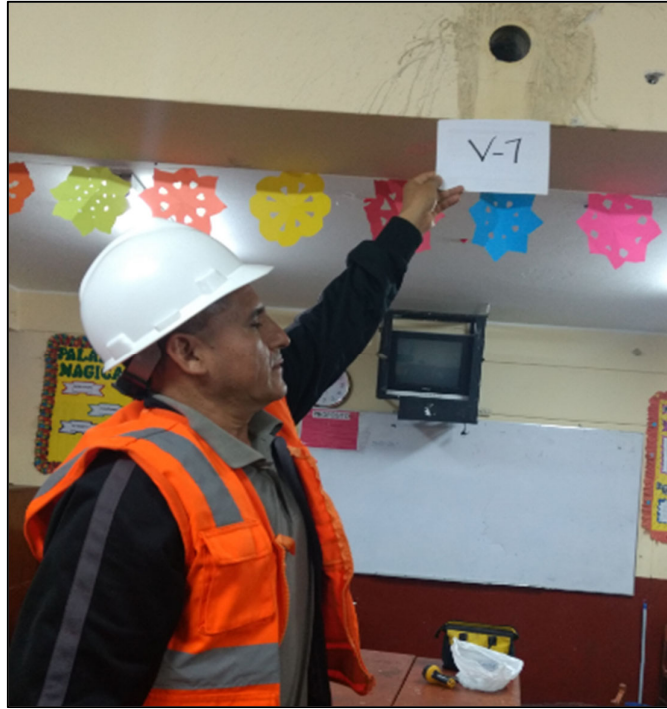
Fotografía N° 19: perforación para la obtención del testigo diamantino V-1 en la viga del 1° piso del pabellón B de la I.E. Antonia Moreno de Cáceres
