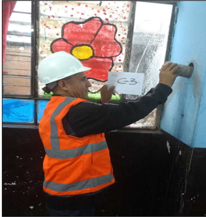
Fotografía N° 17: perforación para la obtención del testigo diamantino C-3 en la columna del 2° piso del pabellón B de la I.E. Antonia Moreno de Cáceres.
