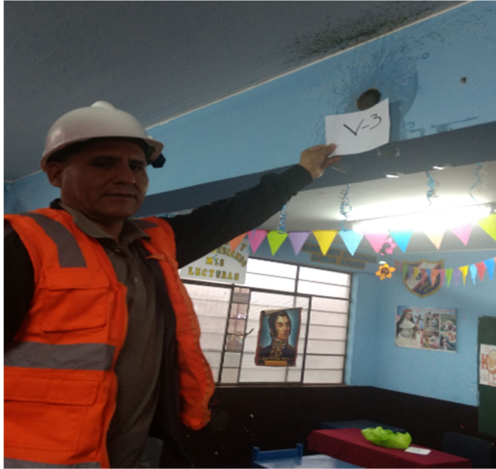
Fotografía N° 23: perforación para la obtención del testigo diamantino V-3 en la viga del 2° piso del pabellón B de la I.E. Antonia Moreno de Cáceres
