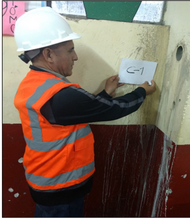
Fotografía N° 13: perforación para la obtención del testigo diamantino C-1 en la columna del 1° piso del pabellón B de la I.E. Antonia Moreno de Cáceres.
