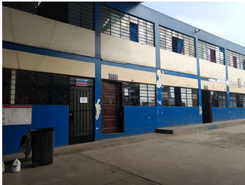
Fotografía N° 2: vista del pabellón B del colegio Antonia Moreno de Cáceres
