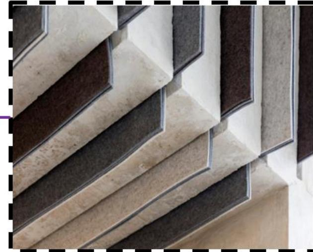
Para solucionar el problema se utilizaron aletas de fieltro en las ranuras fundidas en la superficie del concreto. El fieltro absorbe ruidos extraños y reduce la reverberación. Además de silenciar el interior, estas aletas sobresalientes prestan una calidad táctil inesperada a la arquitectura.
