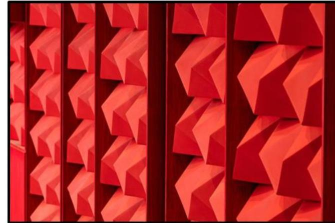
Sus superficies variadas difunden el sonido en múltiples direcciones para una acústica más completa y equilibrada. Los elementos GFRG están alojados en marcos de madera teñidos de rojo escalonados en profundidad, imitando el acristalamiento de tejas del muro cortina.
