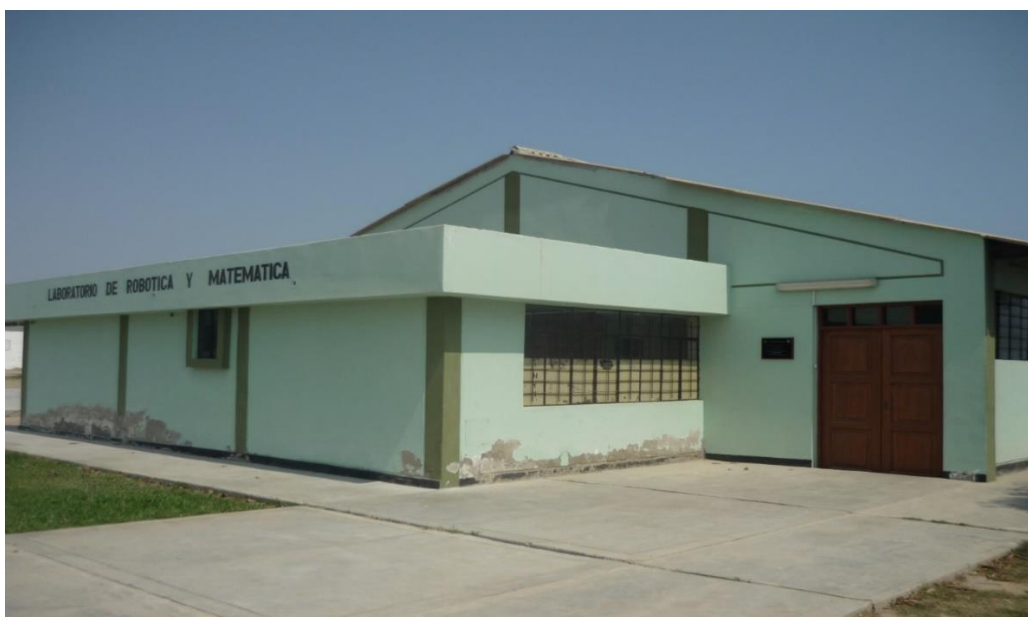
Figura N°22. Parte de la Fachada del Ambiente utilizado como Laboratorio de Robótica y Matemática, se aprecia que es de un solo nivel.
