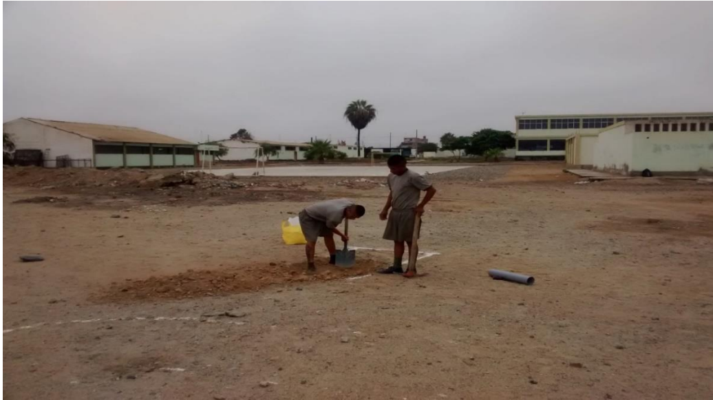
Figura N°24. Ubicación y Excavación de Calicatas con apoyo de Soldados y Cabos del Ejército Peruano.
