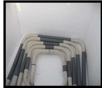
Figura N°55: tubos de PVC enrollados dentro del Tecnopor
