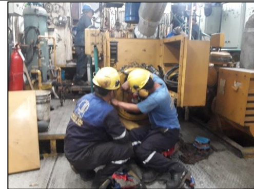
Reflectores de cubierta desmontados
