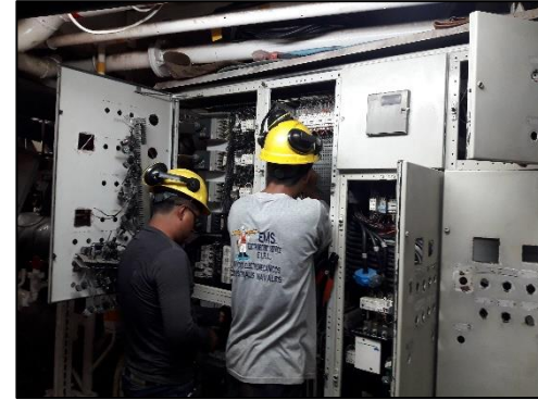
Reparación de tablero de Sala de Refrigeración.
