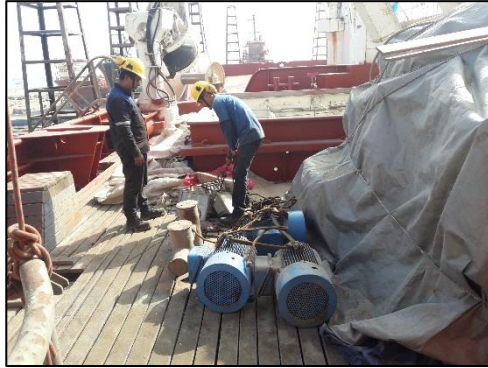
Traslado de motores de electrobombas de Sala de Refrigeración.
