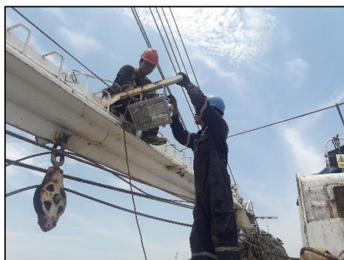
Montaje de reflector en pluma de Superestructura
