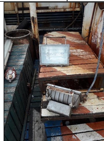
Reflectores de cubierta desmontados
