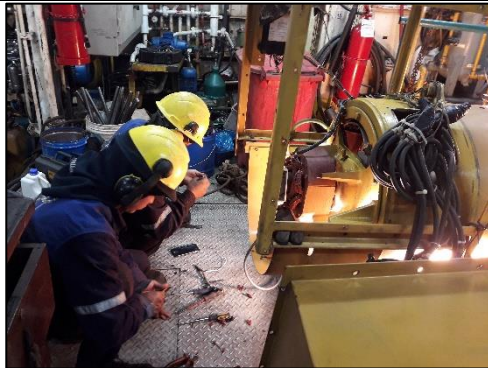
Montaje de reflector en pluma de Superestructura
