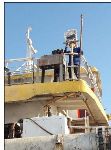
Montaje de reflector en tercer piso de Superestructura.
