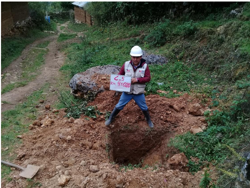
Fotografía N°06: Excavación de calicata C5
