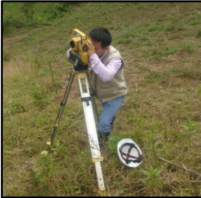
Fotografía N°01: Instalación de estación total en campo Km. 0+600.00
