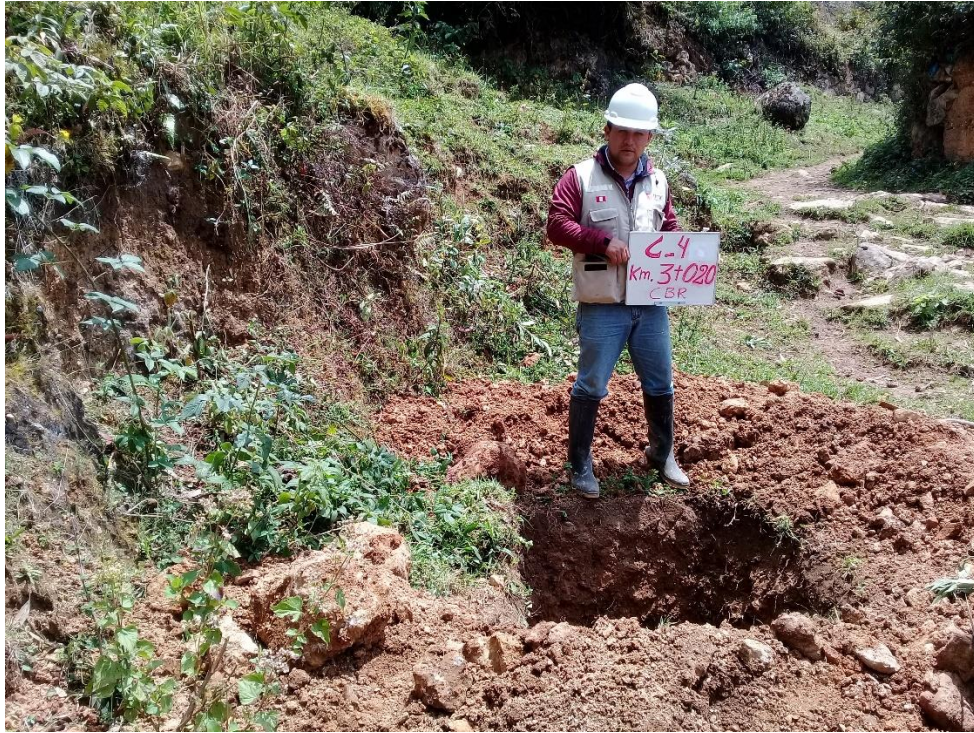
Fotografía N°05: Excavación de calicata C4
