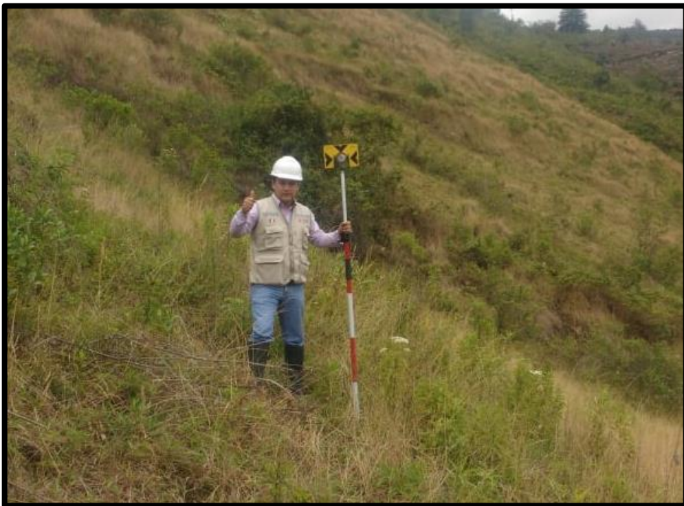
Fotografía N°04: sujeción de prisma en el eje del trazo
