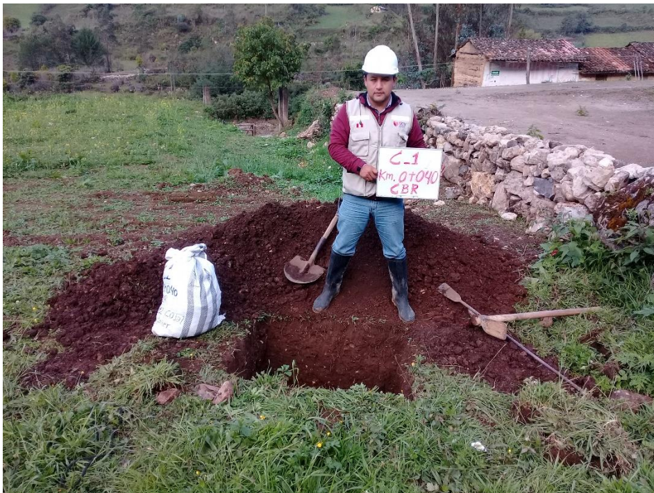
Fotografía N°02: Excavación de calicata C1
