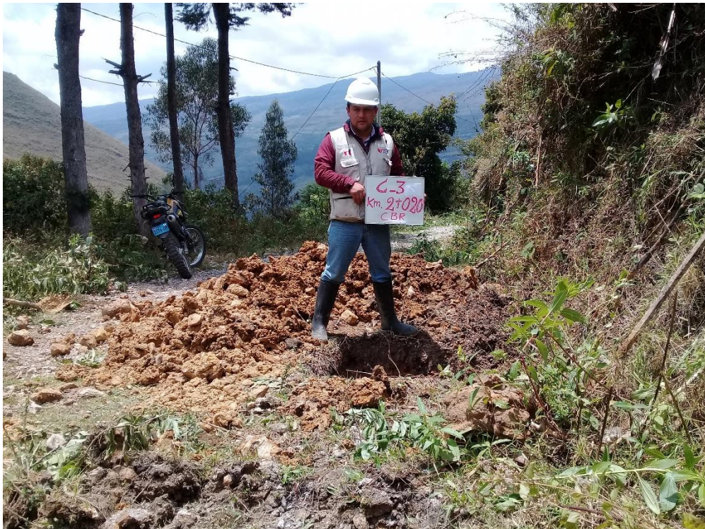
Fotografía N°04: Excavación de calicata C3
