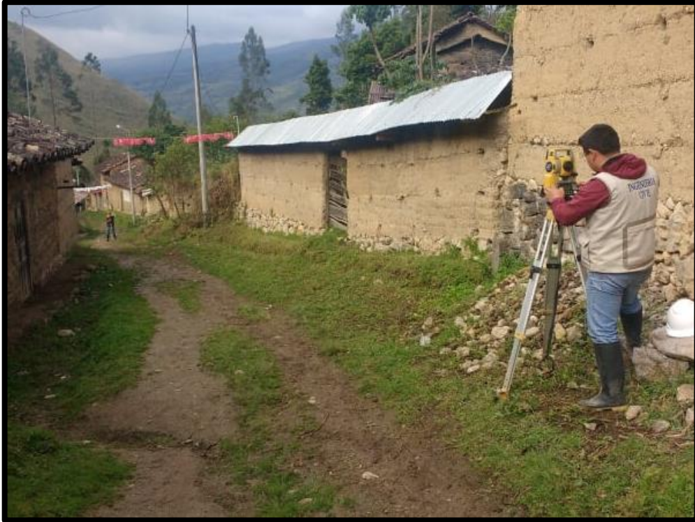
Fotografía N°03: Medición en el Caserío de ishpingo Km. 6+100.00
