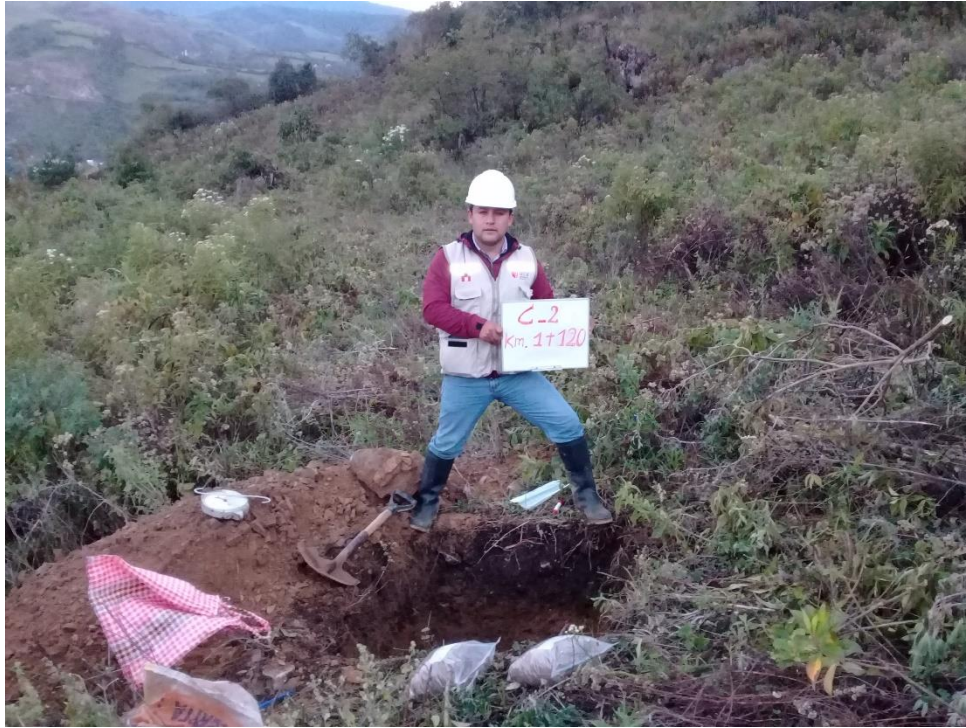
Fotografía N°03: Excavación de calicata C2
