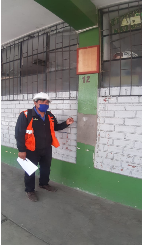
Figura 20. Resane de columna intervenida.
