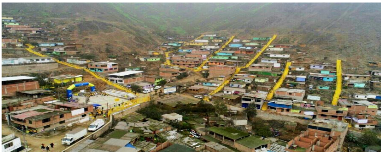
Figura 6. Vista de escaleras solidarias desarrolladas por la municipalidad de Lima se pueden observar las escaleras rectas de color amarillo.
