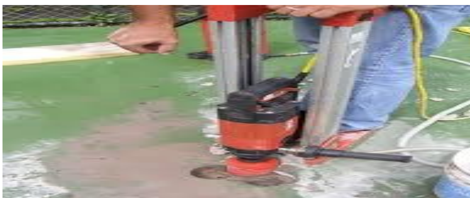
Figura 9. Extracción de núcleo de concreto.
