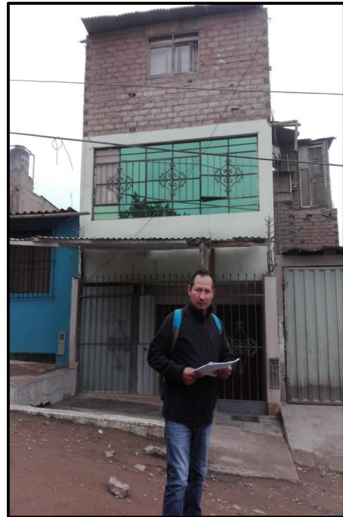
vivienda de albañilería confinada sobredimensionada
