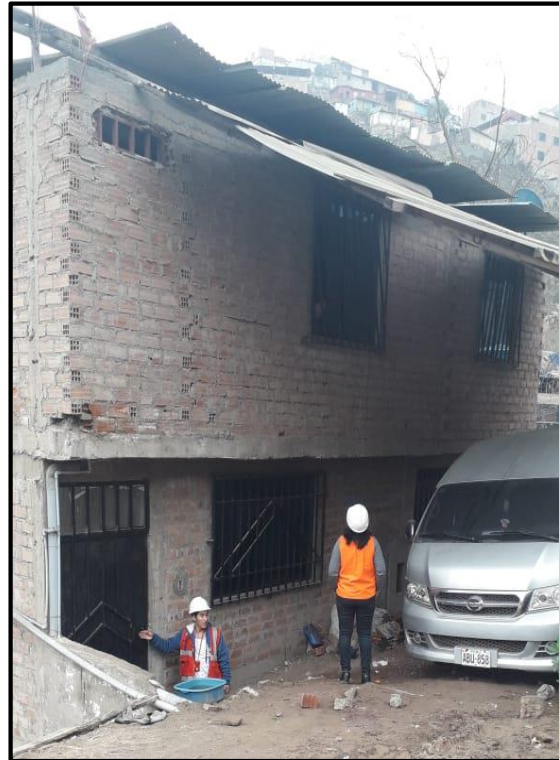
Falta de consideración por servicio de servidumbre - Falta de columnas estructural
