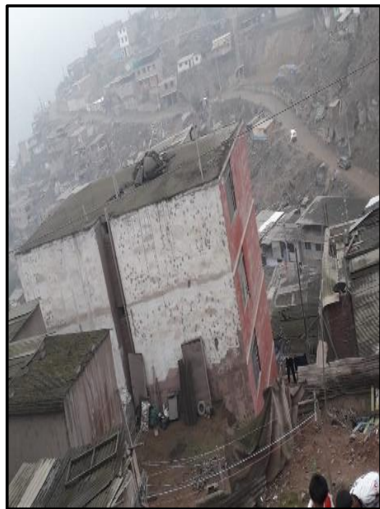
Edificaciones de vivienda que no cumplen con los parámetros de acuerdo a la zonificación
