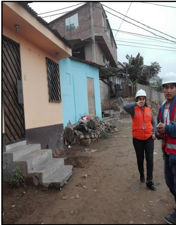
Escalera construida en área de servidumbre
