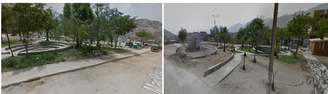
Figura 73 y 74. Anfiteatro deteriorado. Fuente: Google Earth
