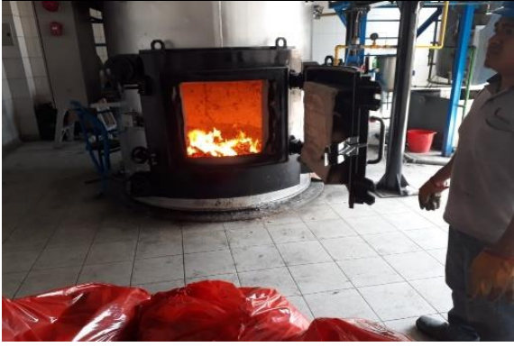
Equipo incinerador pirolítico funcionando
