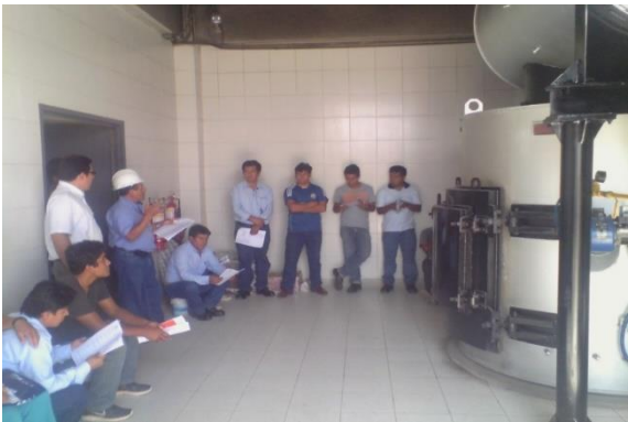
Capacitación en buen uso de equipo incinerador pirolítico
