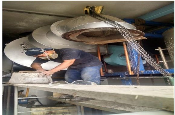
Reparación de refractario de incinerador pirolítico
