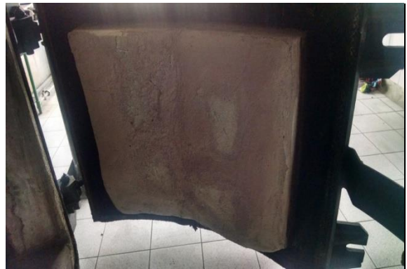
Refractario de puerta de cámara primaria reparado
