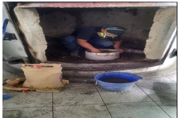
Refractario de cámara primaria reparado
