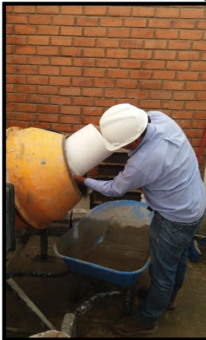
Figura 24 Preparación de concreto
