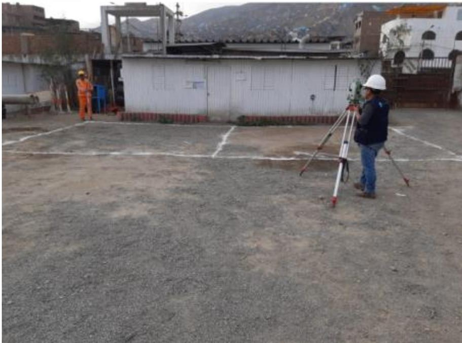
**FIGURA 34: Levantamiento con estación total**
