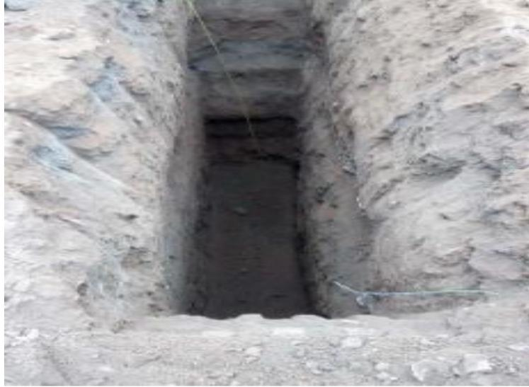
**FIGURA 15: Excavación de calicata para obtención de datos**
