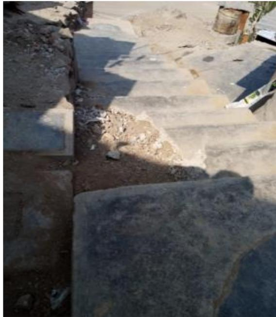
**FIGURA 21: Demolición de escaleras para instalación de redes de agua.**
