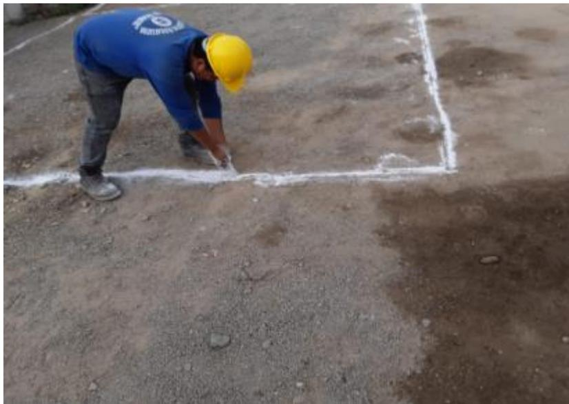
**FIGURA 32:Trazo de ejes longitudinales**
