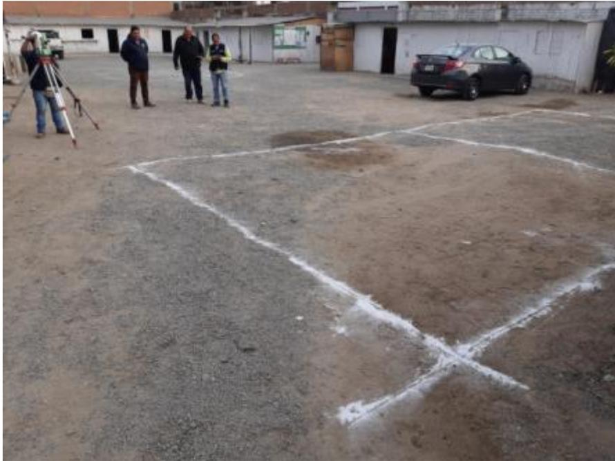
**FIGURA 35:** Trazado final del módulo a ensayar
