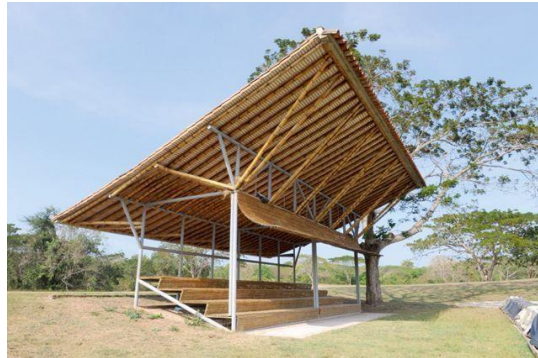
Figura 4: ejemplo de cubierta de material bambú para tribunas
