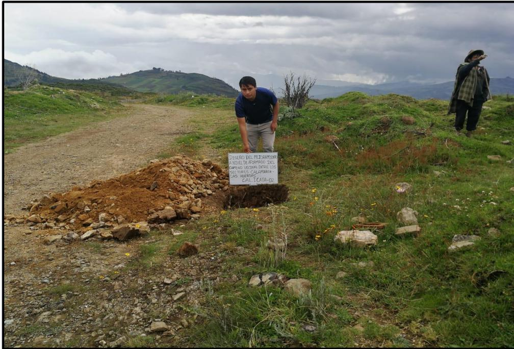
Fotografía 9: Recolección de muestras de la vía existente para el estudio de mecánica de suelos
