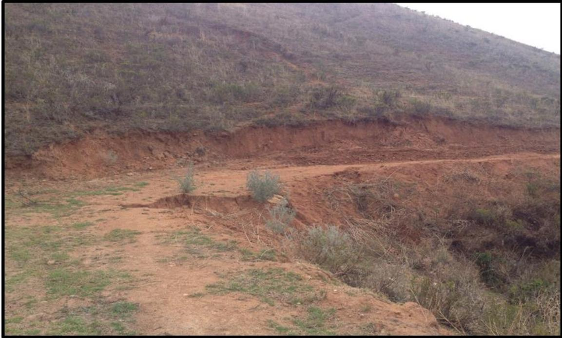
Fotografía 3: Vista de plataforma de vía existente en mal estado – Las Huertas se deberá proyectar alcantarillas de paso
