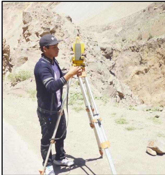
Fotografía 6: Estudio topográfico toma de datos de la vía existente
