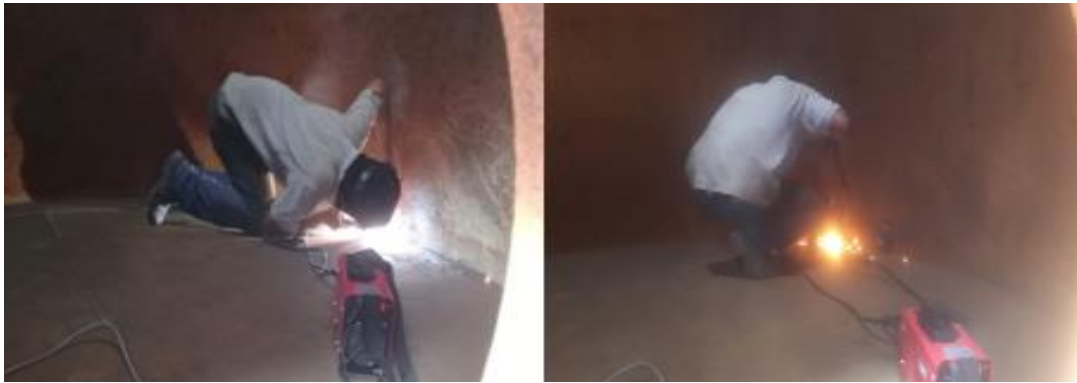
Figura 13. Trabajos de corte y soldadura realizados en la parte interna del reservorio.
