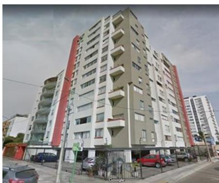
Figura 2. Edificación de 13 niveles.
