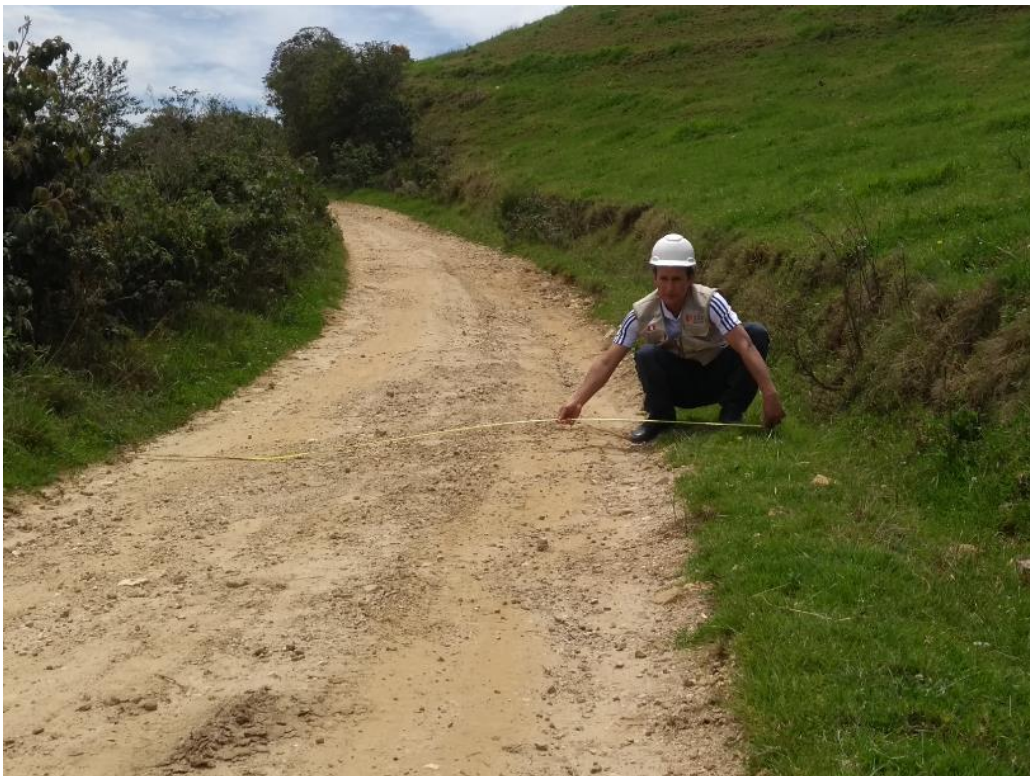
Foto N° 4: Se aprecia que la capa de rodadura se encuentra en mal estado del camino vecinal.
