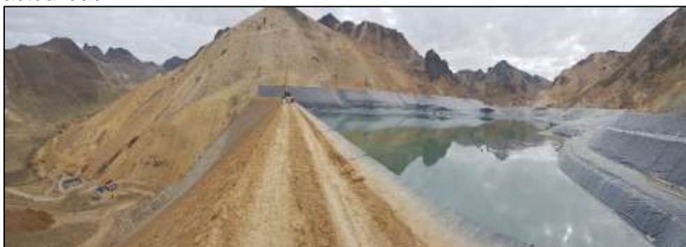
Figura N° 1: Vista fotográfica de la presa de relaves Inmaculada en la actualidad
