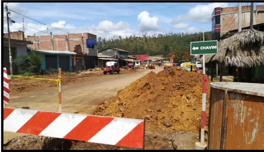
Figura 2: Mantenimiento de sistema de alcantarillado por colapsos.
