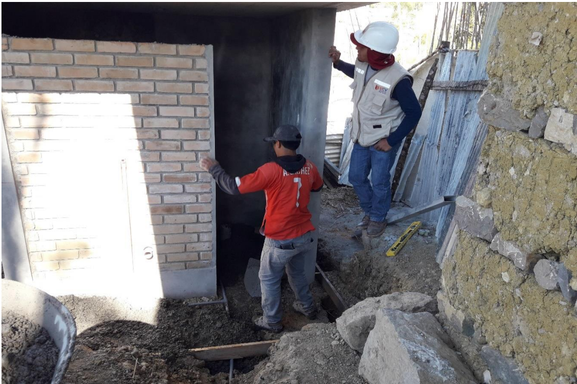
Ilustración 68. vaciado de piso. frente 1.
