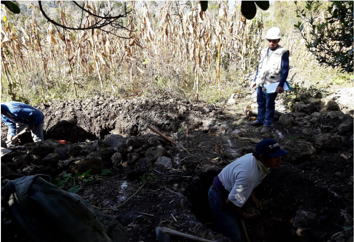
Ilustración 32. Excavación para biodigestor, frente 2.
