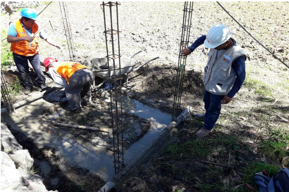
Ilustración 35. Nivelado de cemento corrido.
