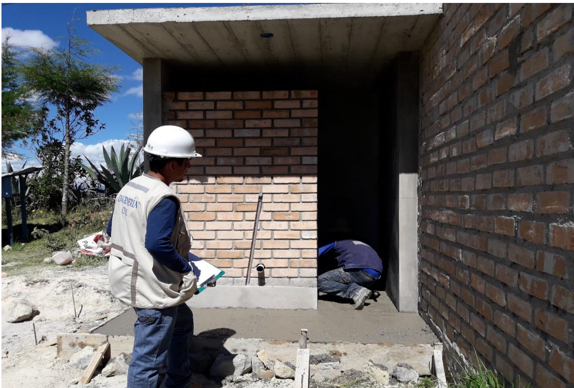
Ilustración 69. Vaciado de piso frente 2.
