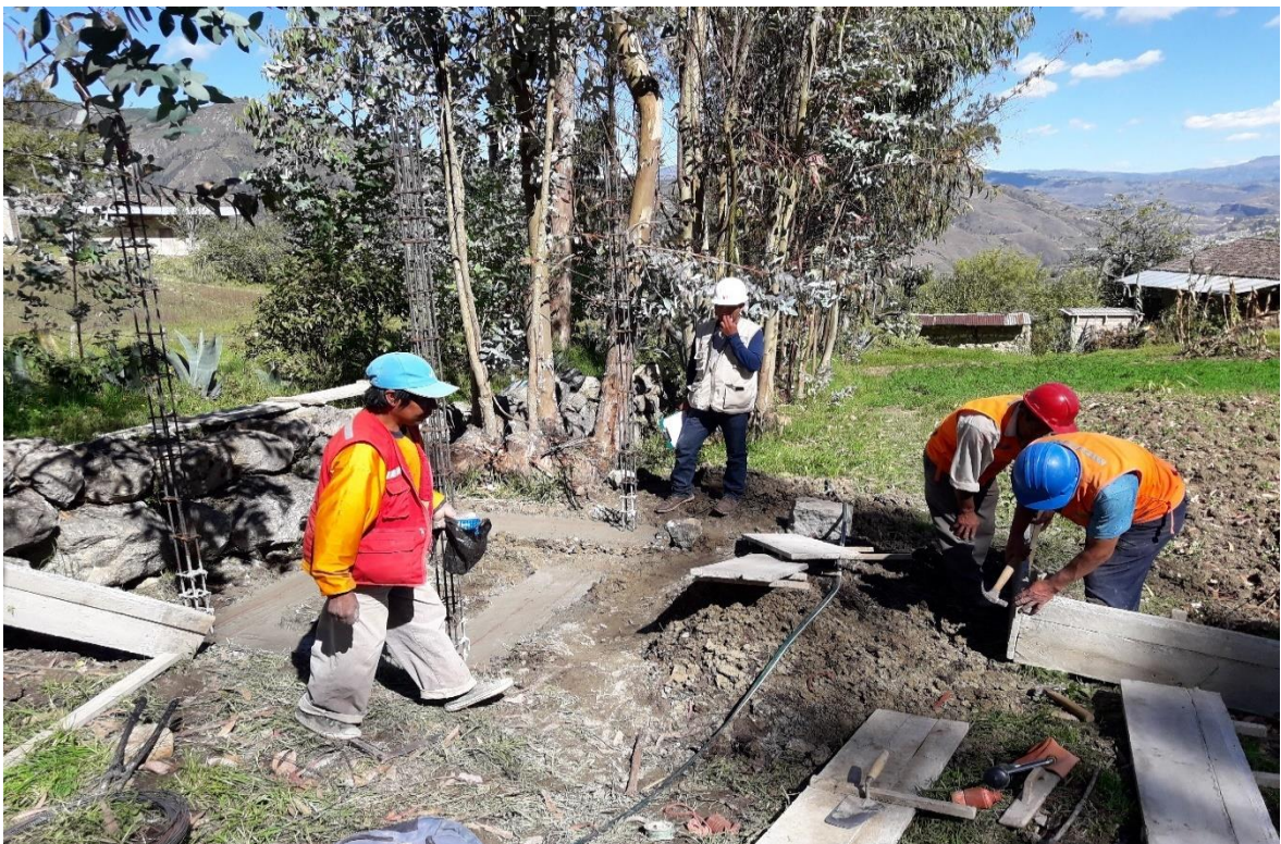
Ilustración 37. inicio de encofrado de sobrecimiento.
