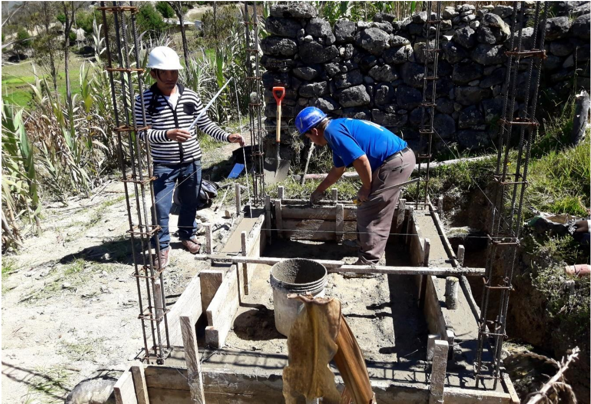
Ilustración 44. Nivelado de sobrecimiento vaciado.
