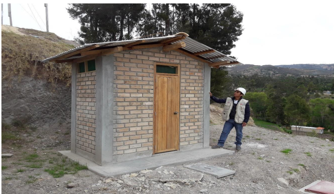
Ilustración 25. Estructura terminada de UBS, obra N° 3.
