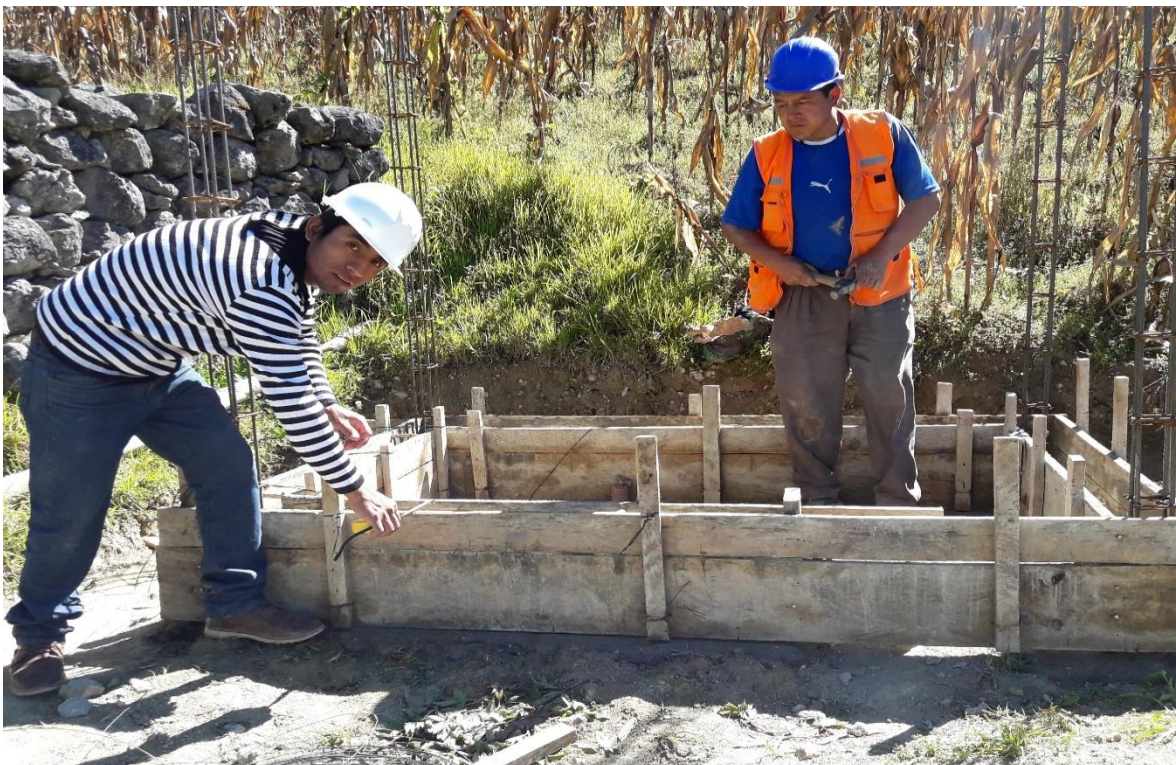
Ilustración 41. Sacando medidas de sobrecimiento de otra UBS.
