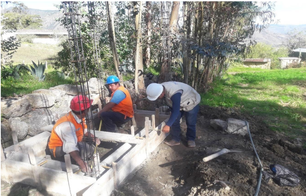
Ilustración 39. Midiendo ancho de sobrecimiento, operarios verificando escuadra.
