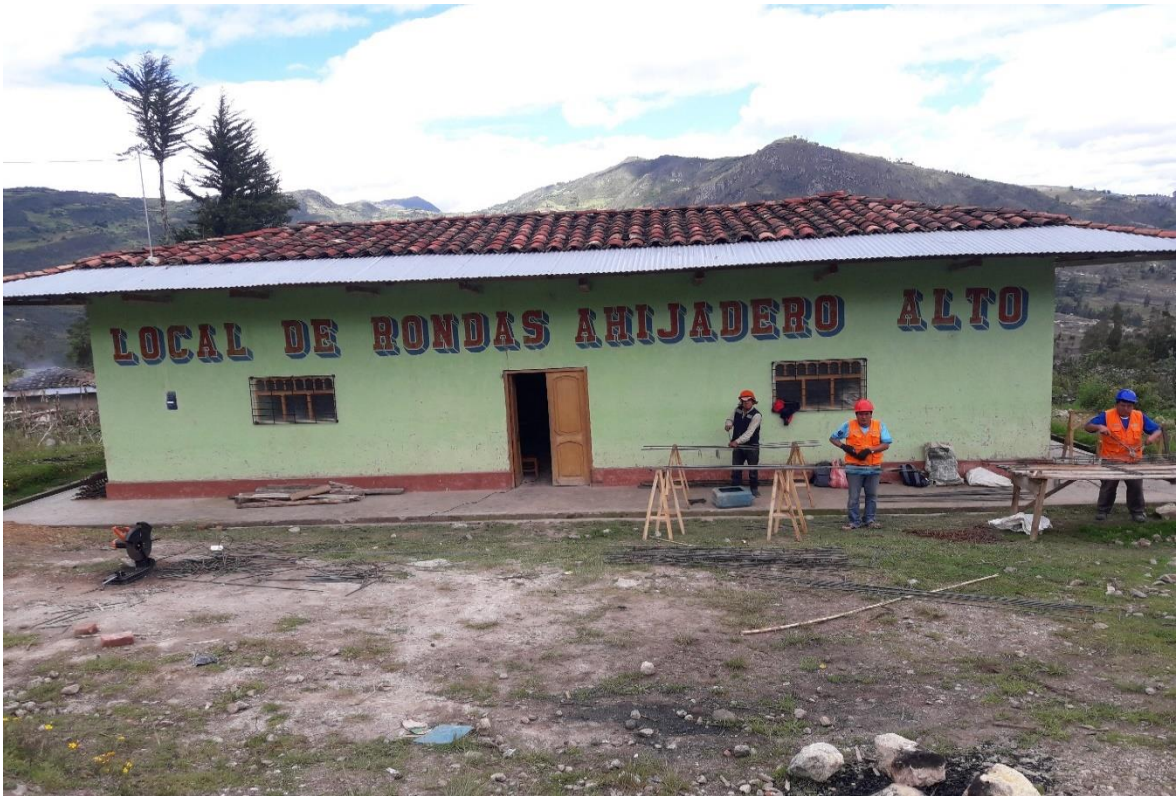
Ilustración 56. Habilitación de acero, foto panorámica.
