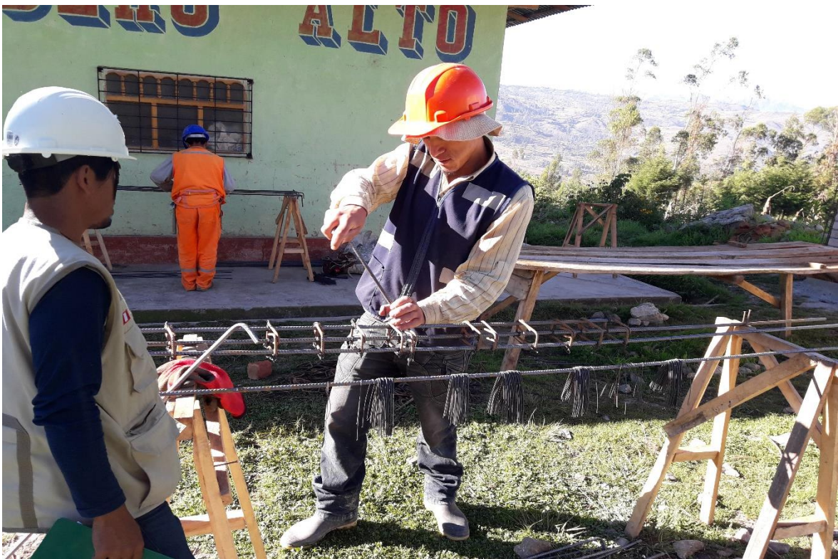
Ilustración 55. Armado de columnas.
