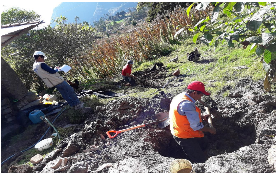
Ilustración 31. Excavación para biodigestor, frente 1.
