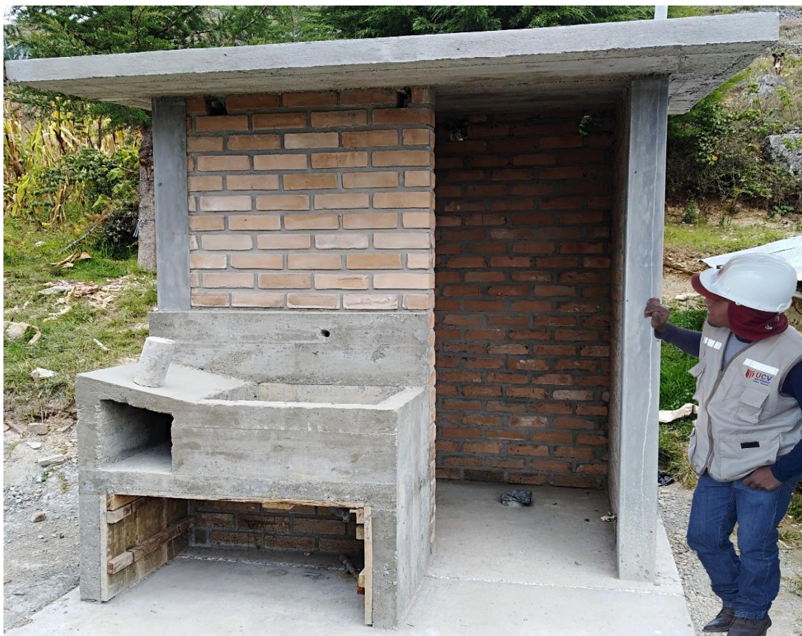
Ilustración 24. Estructura terminada de UBS, obra N° 2.
