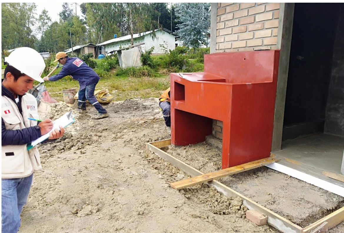
Ilustración 71. Vaciado de piso obra 3.
