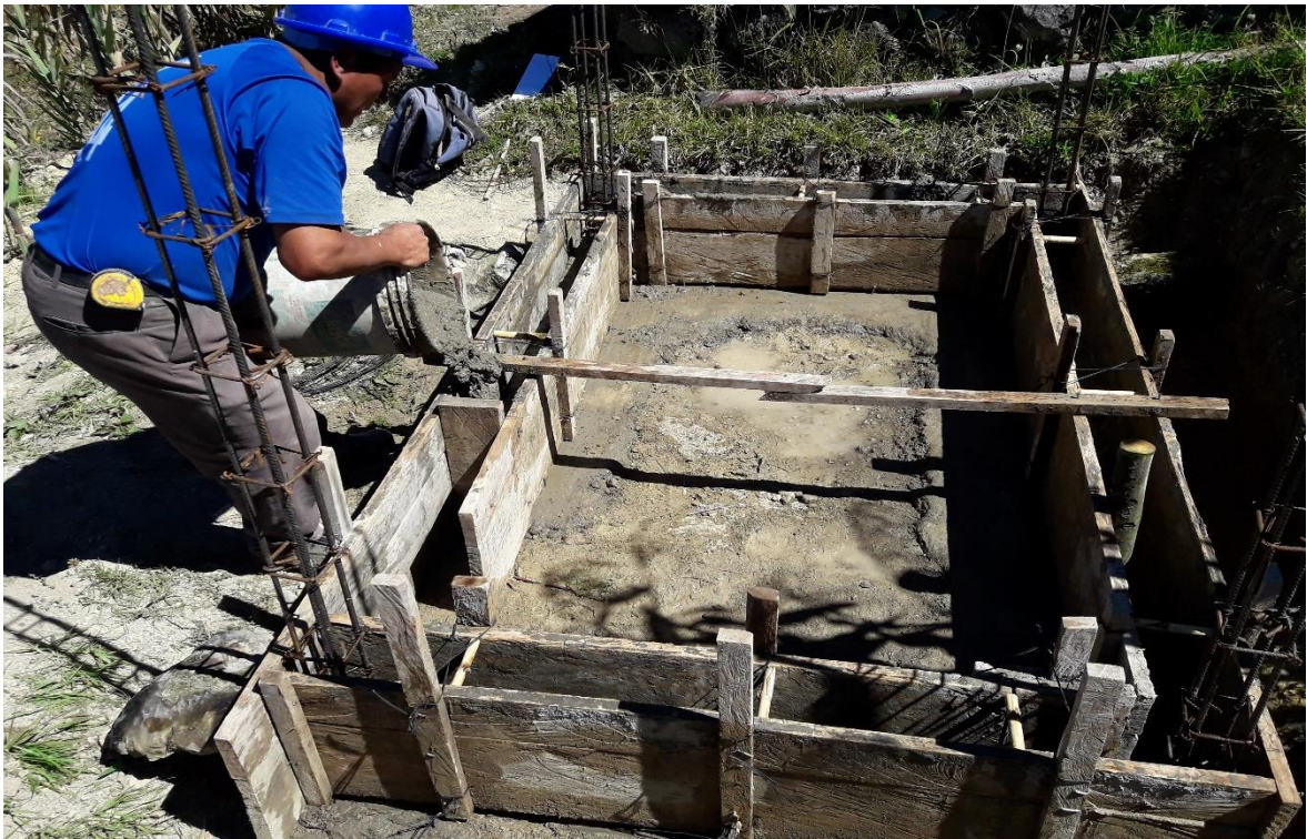
Ilustración 42. Llenado con latas de sobrecimiento.
