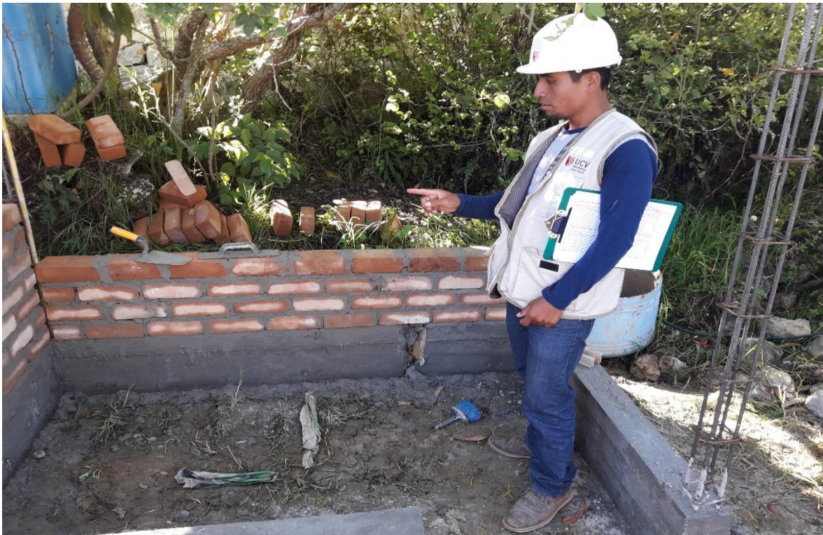
Ilustración 48. Asentado de ladrillo, conteo de unidades.
