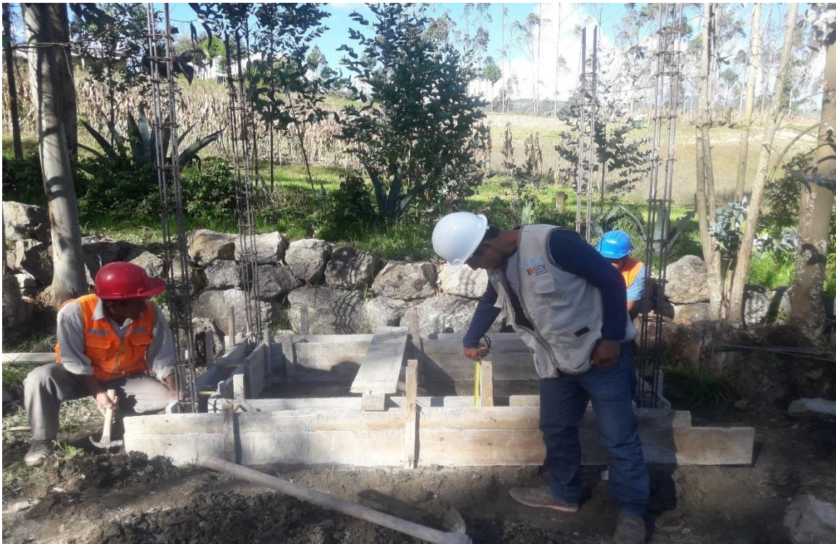
Ilustración 40. Midiendo altura de sobrecimiento.
