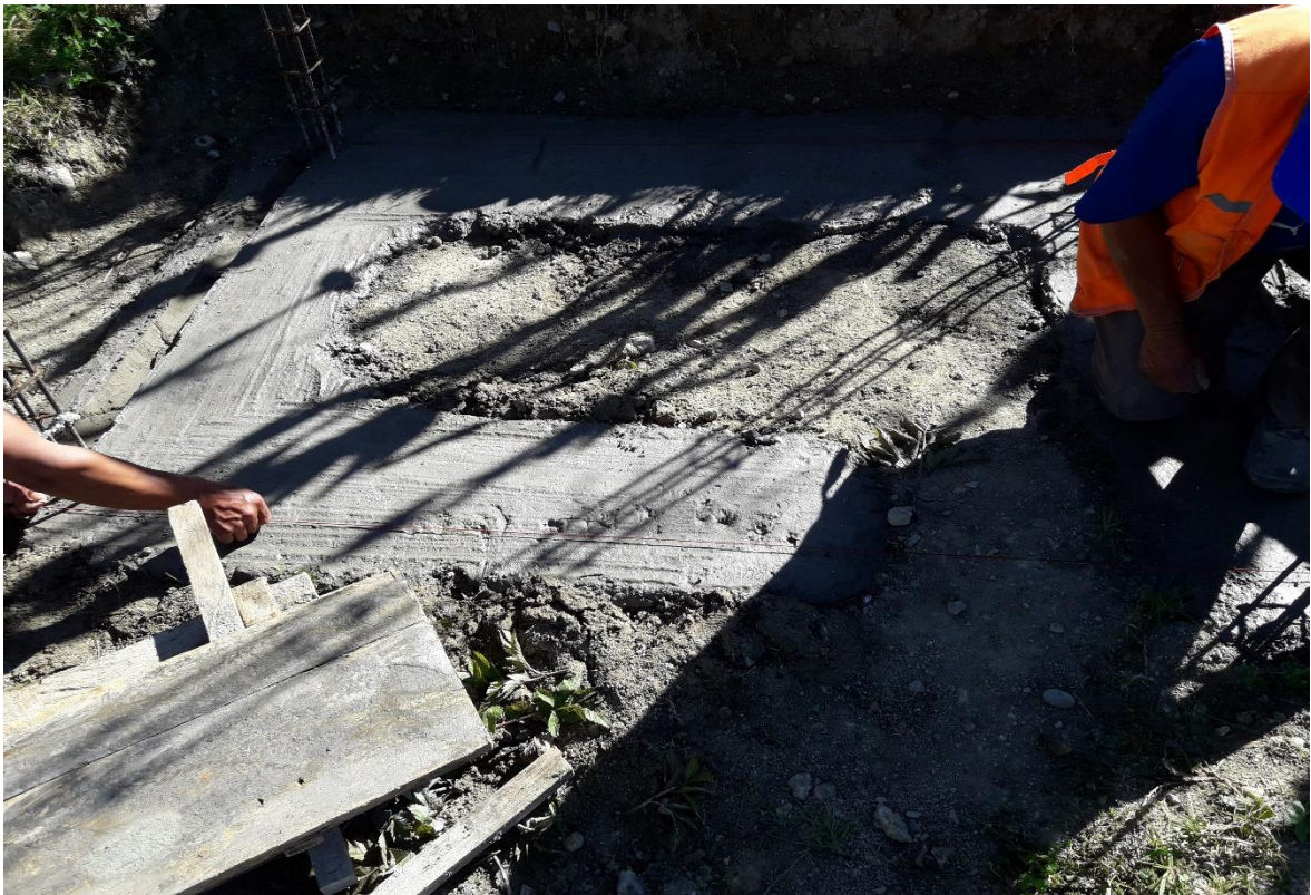
Ilustración 36. Cimiento corrido listo para encofrar.
