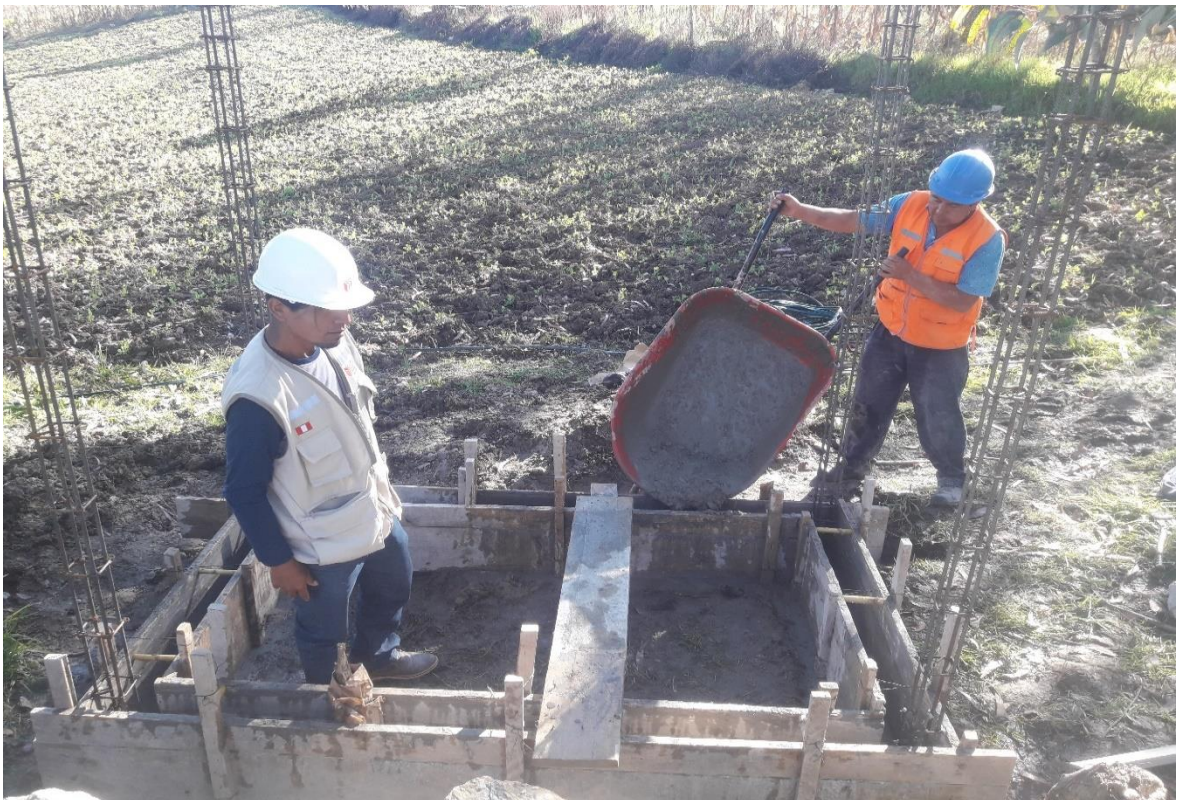
Ilustración 43. Vaciado con carretilla de sobrecimiento.
