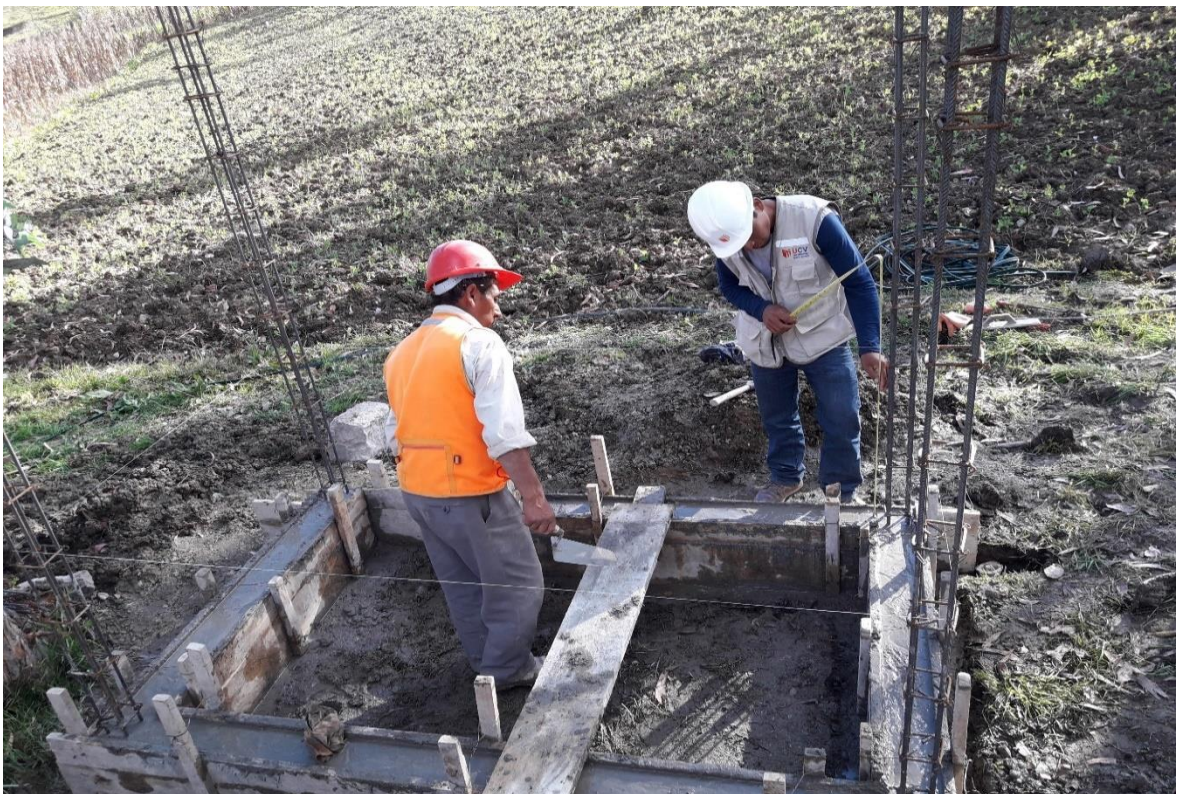
Ilustración 45. Nivelado de sobrecimiento vaciado de otra UBS.
