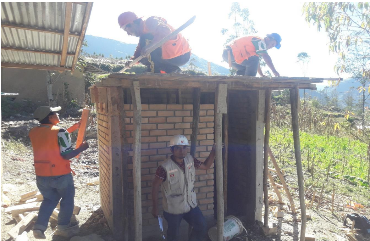
Ilustración 59. Encofrado de techo.
