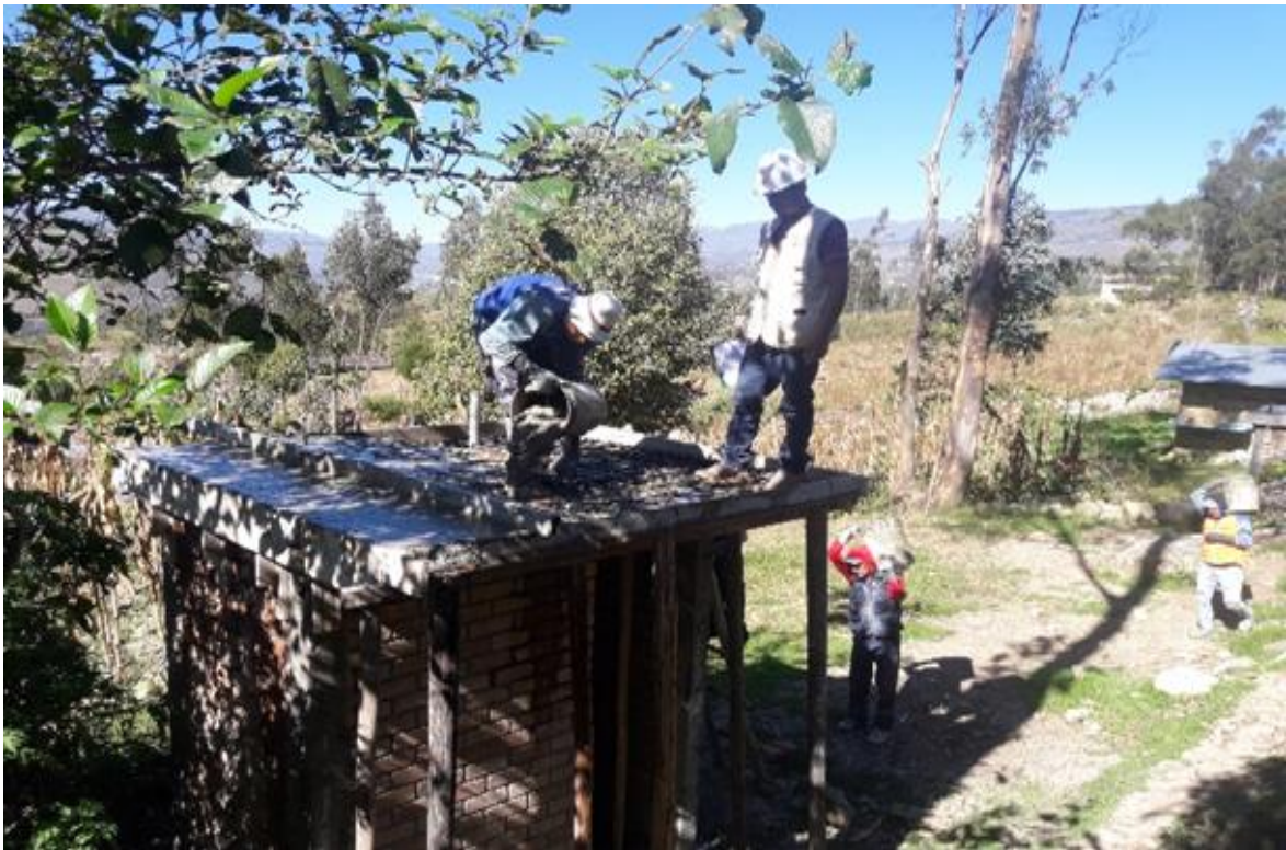
Ilustración 62. Vaciado y regleado de techo.
