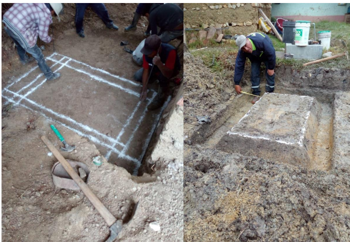
Ilustración 27. Trazado y excavación para cimiento corrido.
