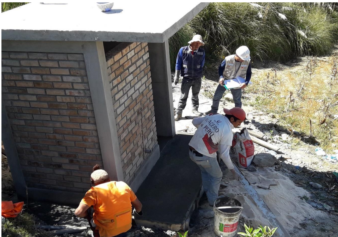
Ilustración 70. vaciado de piso, obra 2.
