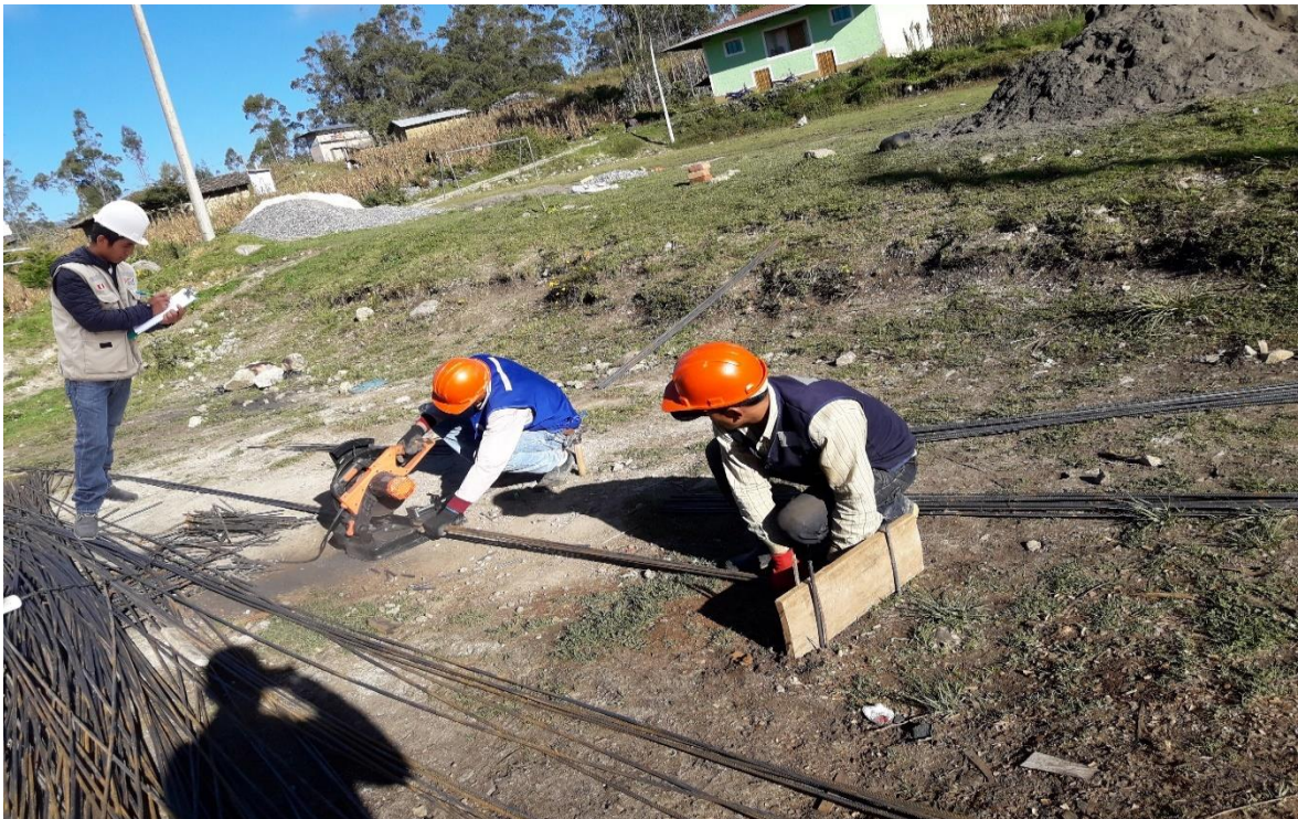
Ilustración 54. Habilitación de acero.
