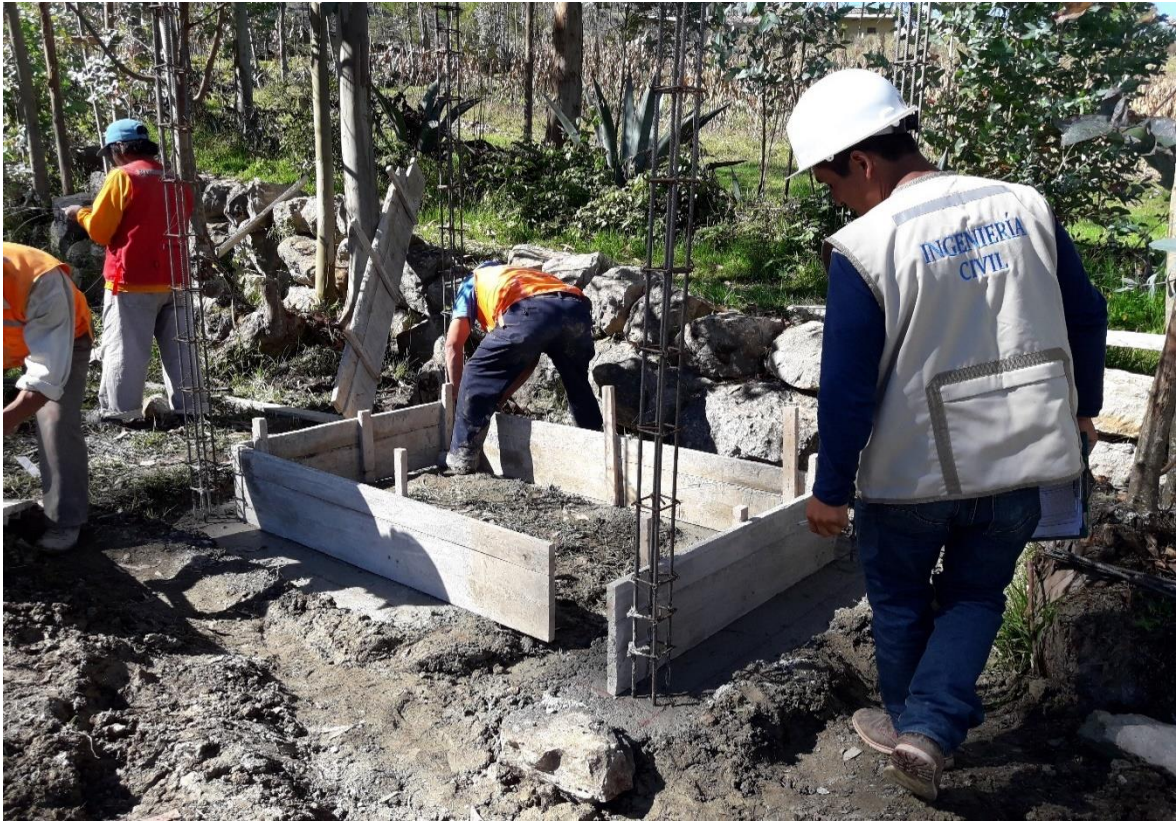
Ilustración 38. Puesta de tableros para sobrecimiento.
