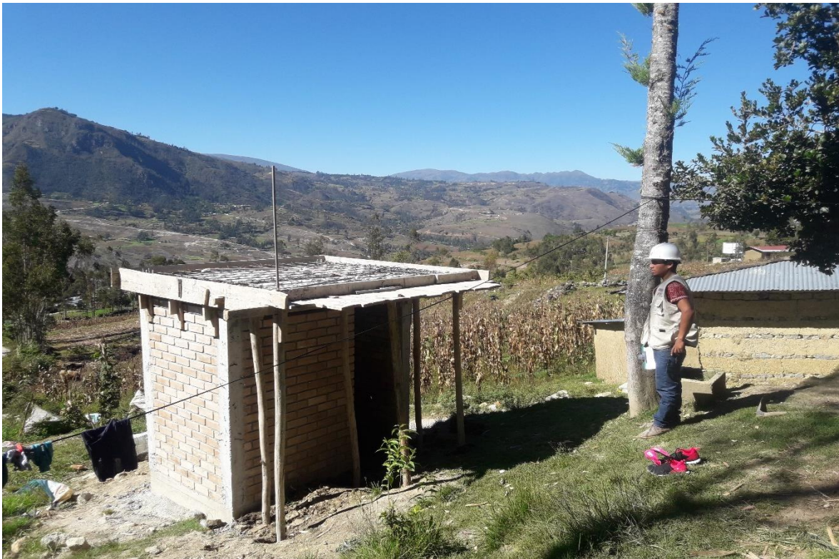
Ilustración 60. Encofrado de techo vista panorámica.
