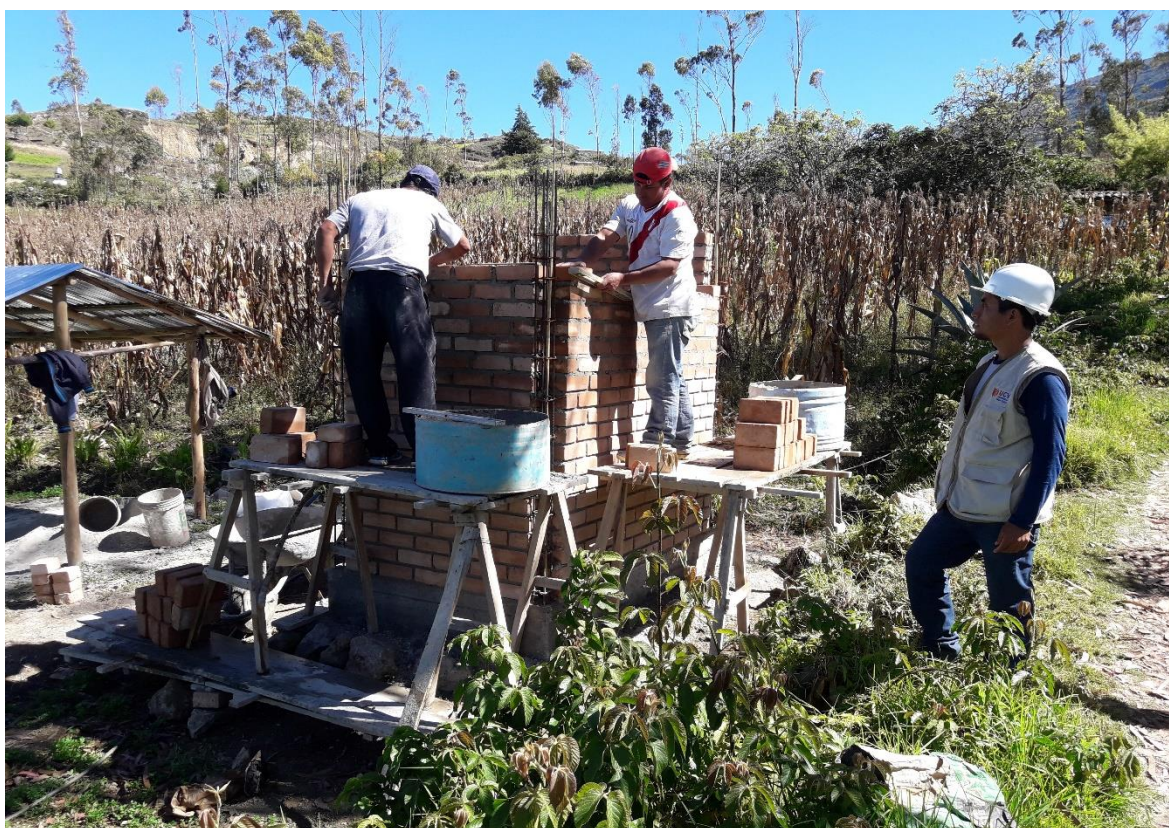
Ilustración 47. Asentado de ladrillo, llegando a su altura normal.
