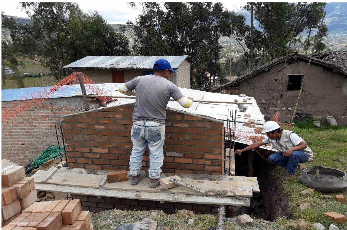
Ilustración 50. asentado de ladrillo obra 3, dándole forma punta.
