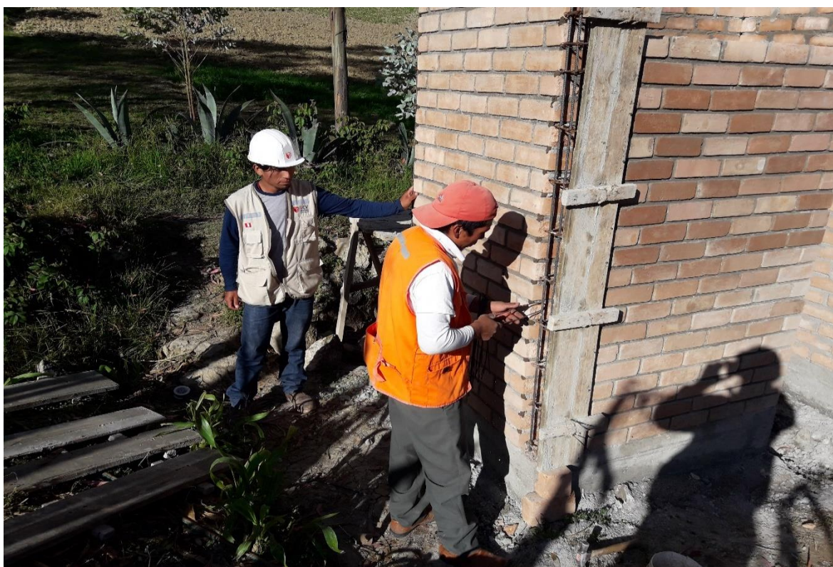
Ilustración 51. Inicio de encofrado de columnas.
