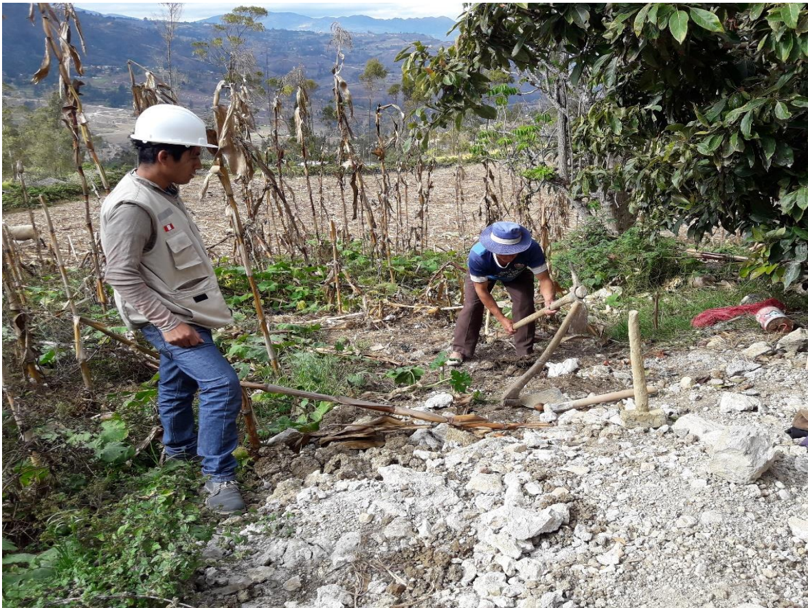
Ilustración 30. Inicio de excavación para biodigestor.
