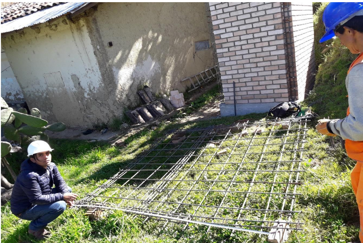
Ilustración 57. Armado de parrilla para techo.
