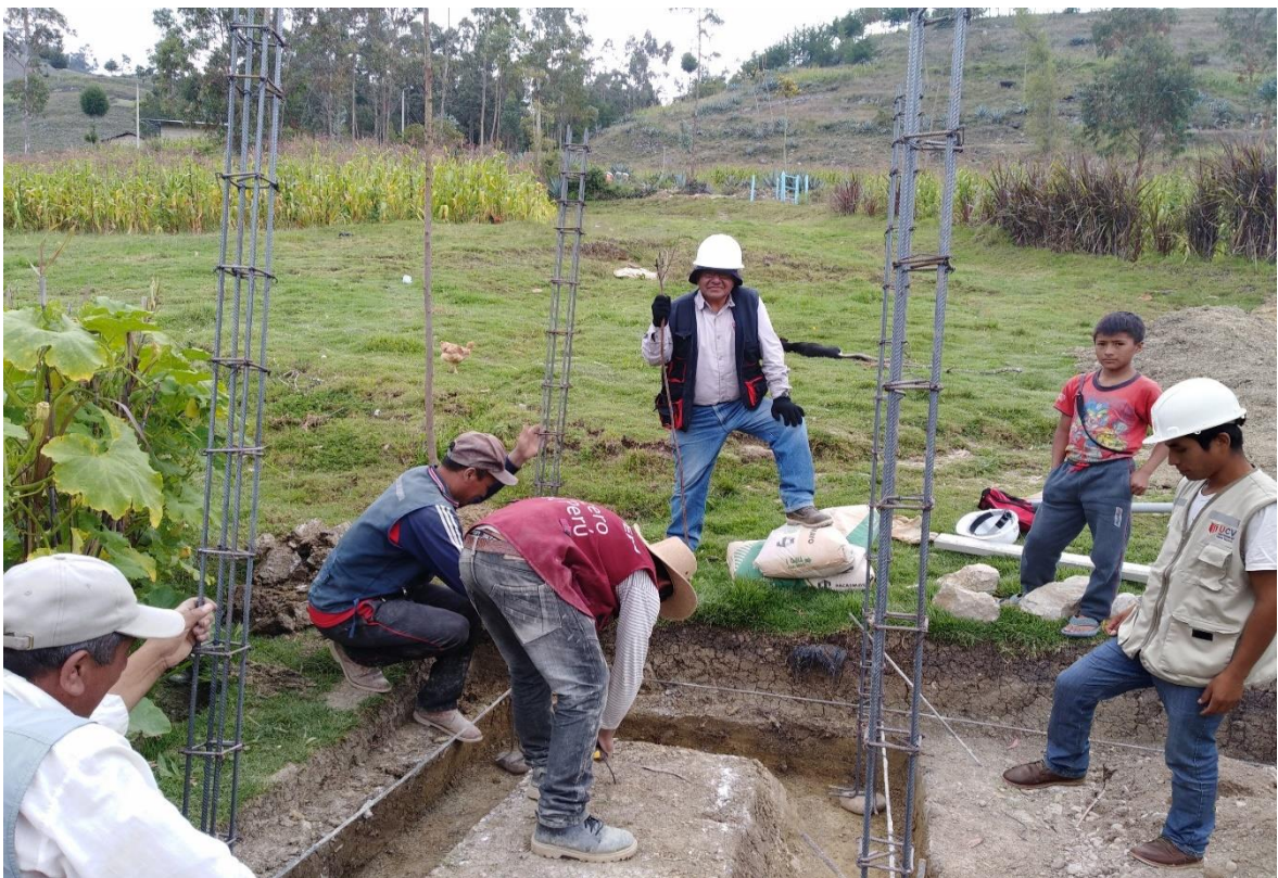
Ilustración 33. Parado de columnas.
