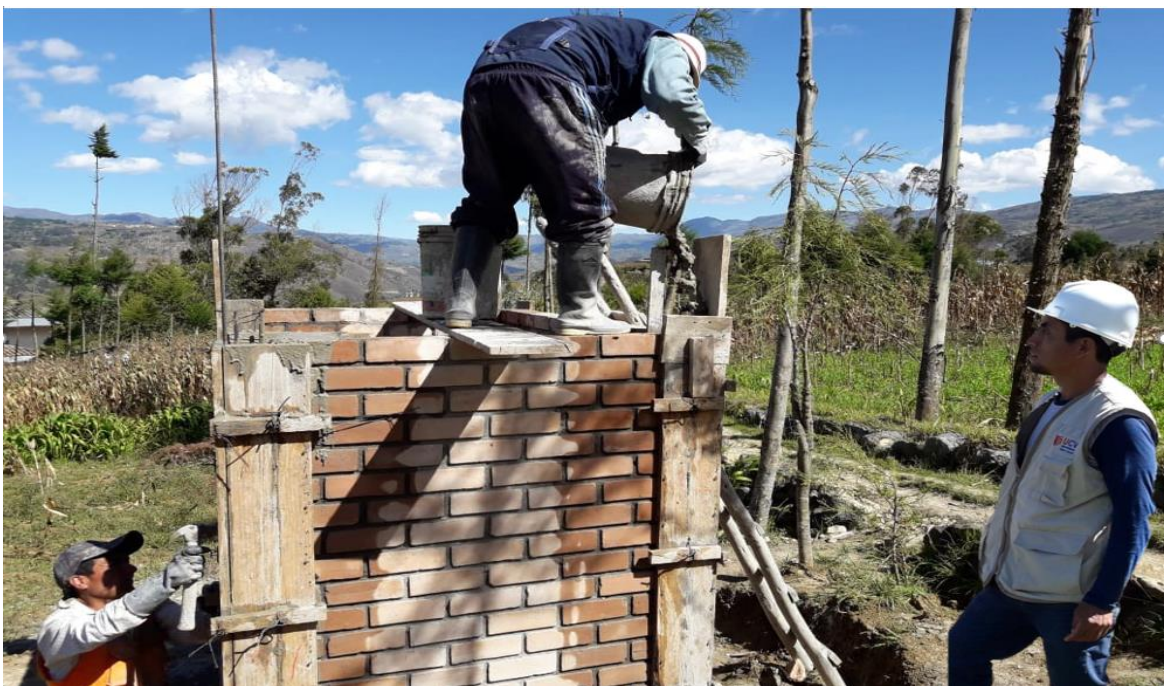
Ilustración 53. Vaciado de columnas.
