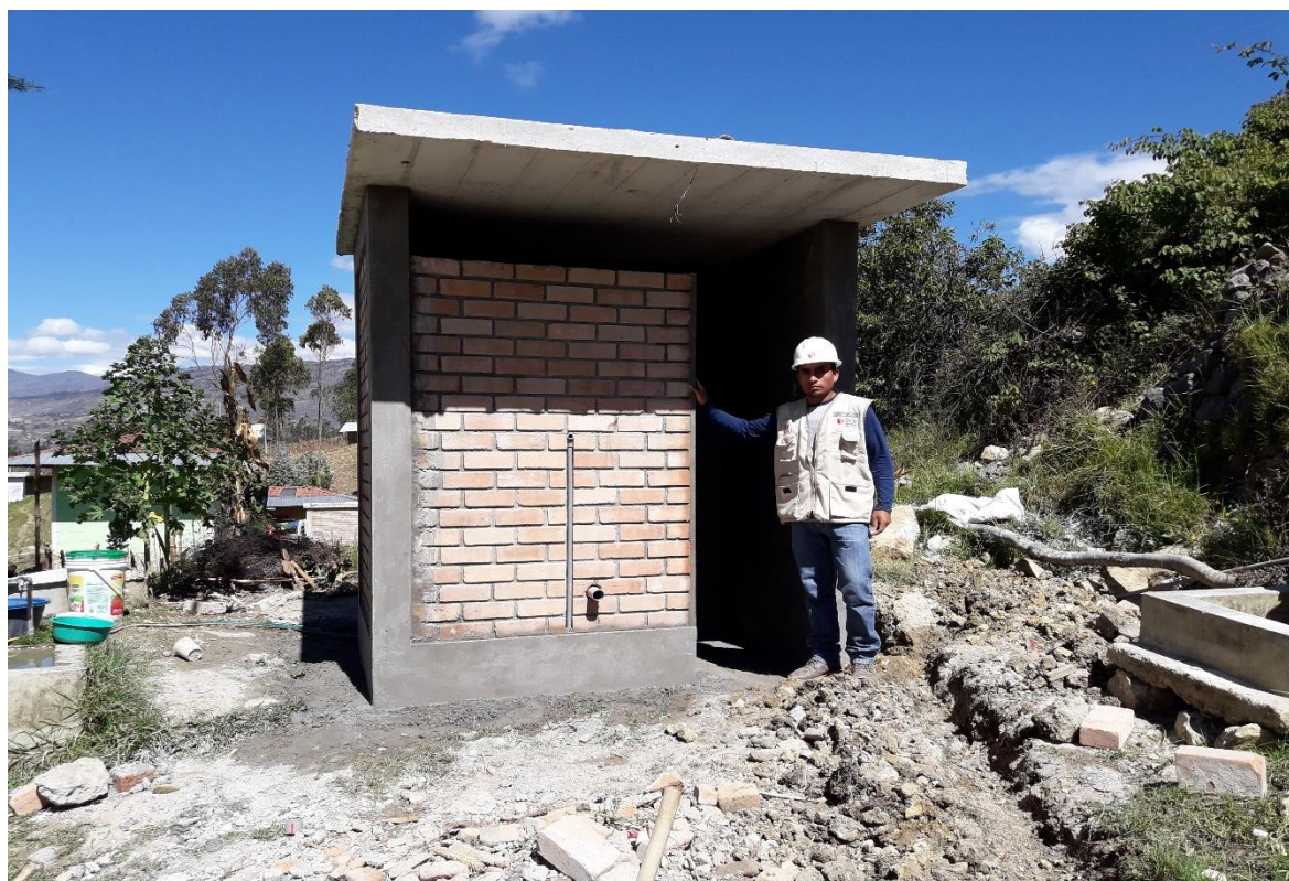
Ilustración 23. Estructura terminada de UBS, obra N° 1.
