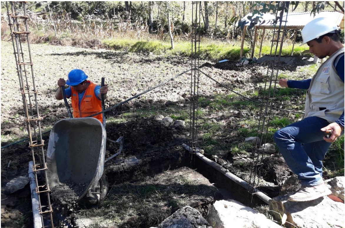
Ilustración 34. Vaciado de cemento corrido primera carretillada.
