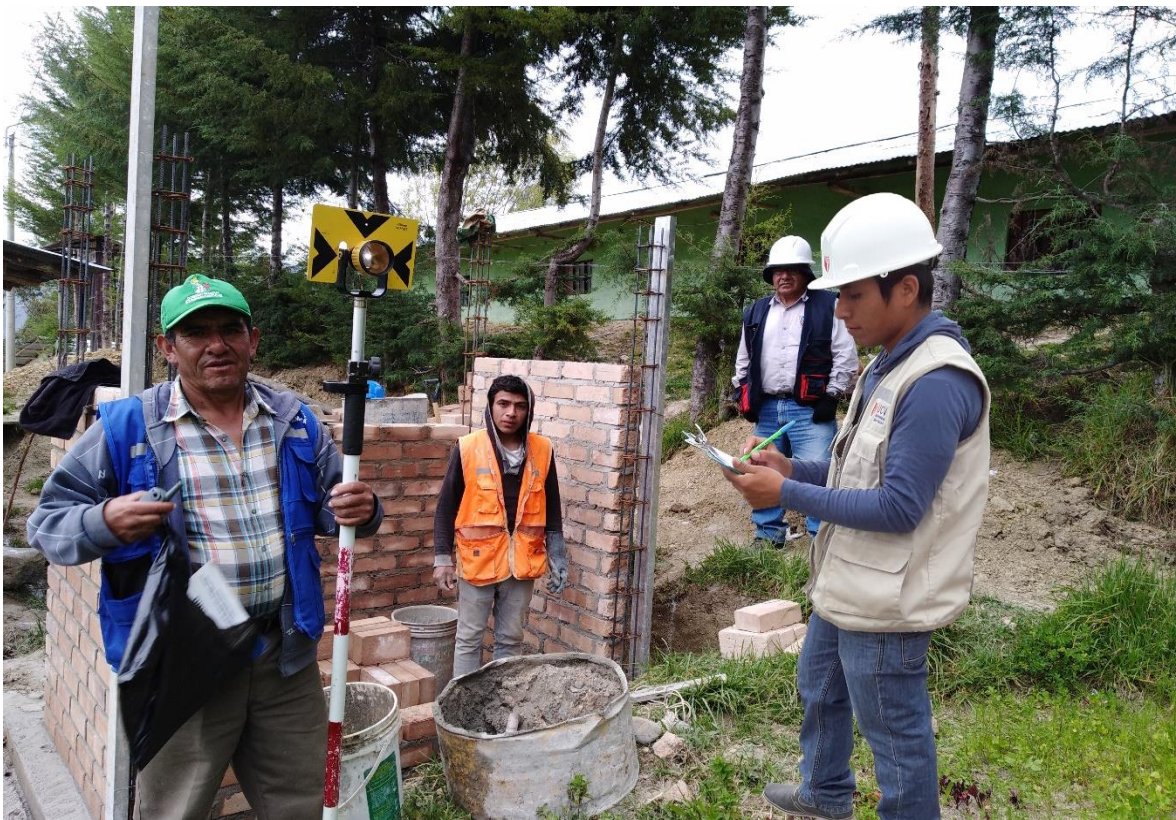
Ilustración 49. Asentado de ladrillo obra 2.
