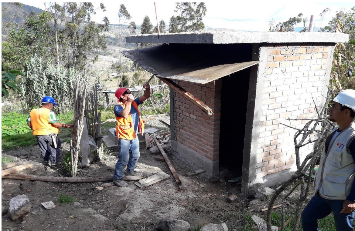
Ilustración 64. Desencofrado de techo.
