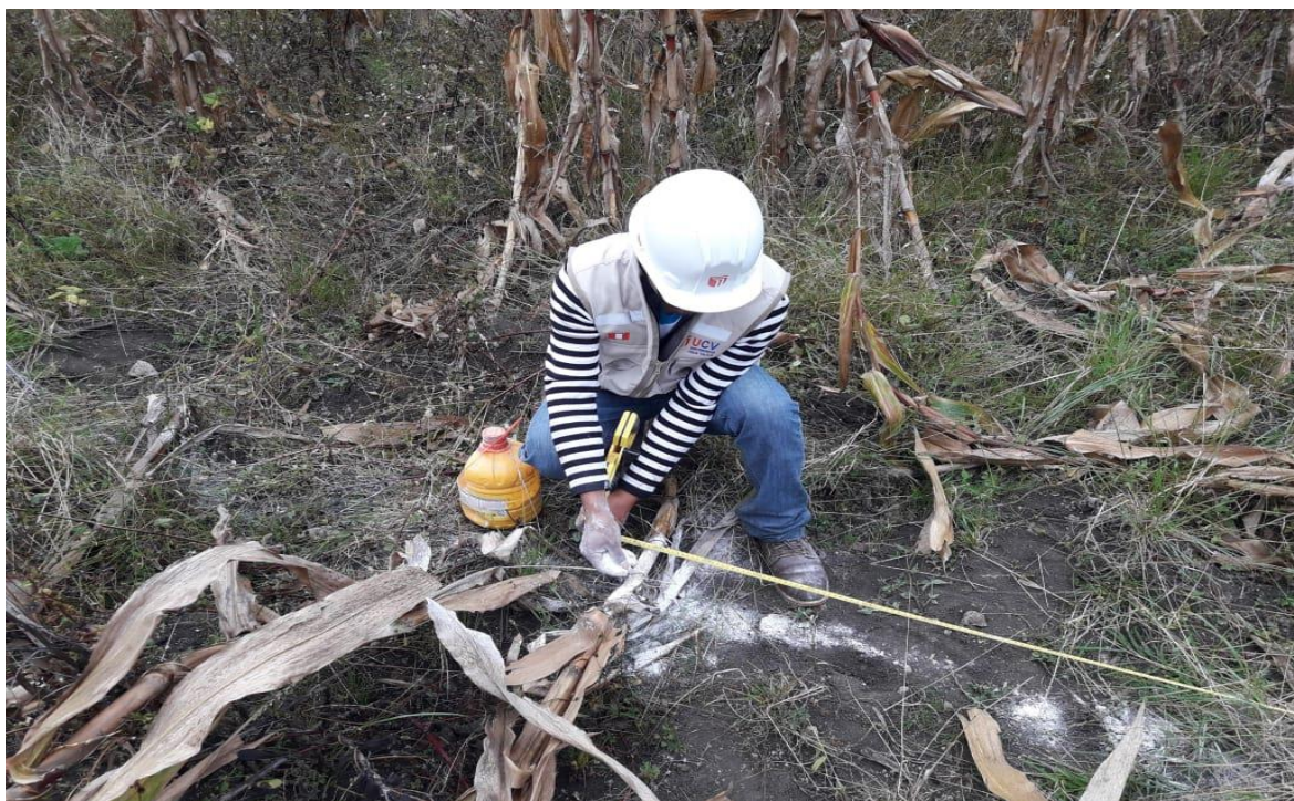
Ilustración 26. Trazado para excavación de zanja.
