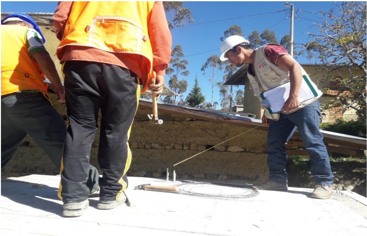
Ilustración 58. Encofrado de techo. vista superior.
