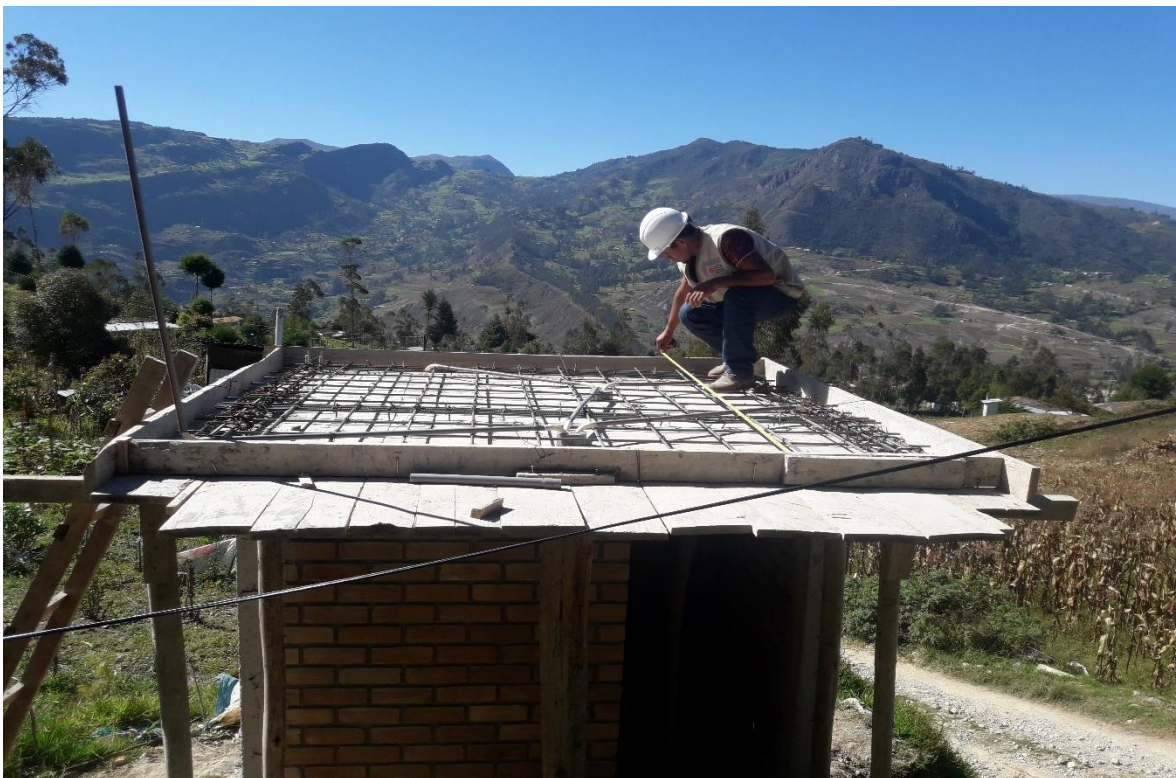
Ilustración 61. Techo con parrilla listo para vaciado.
