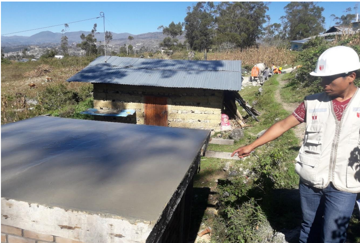
Ilustración 63. Vaciado listo de techo.
