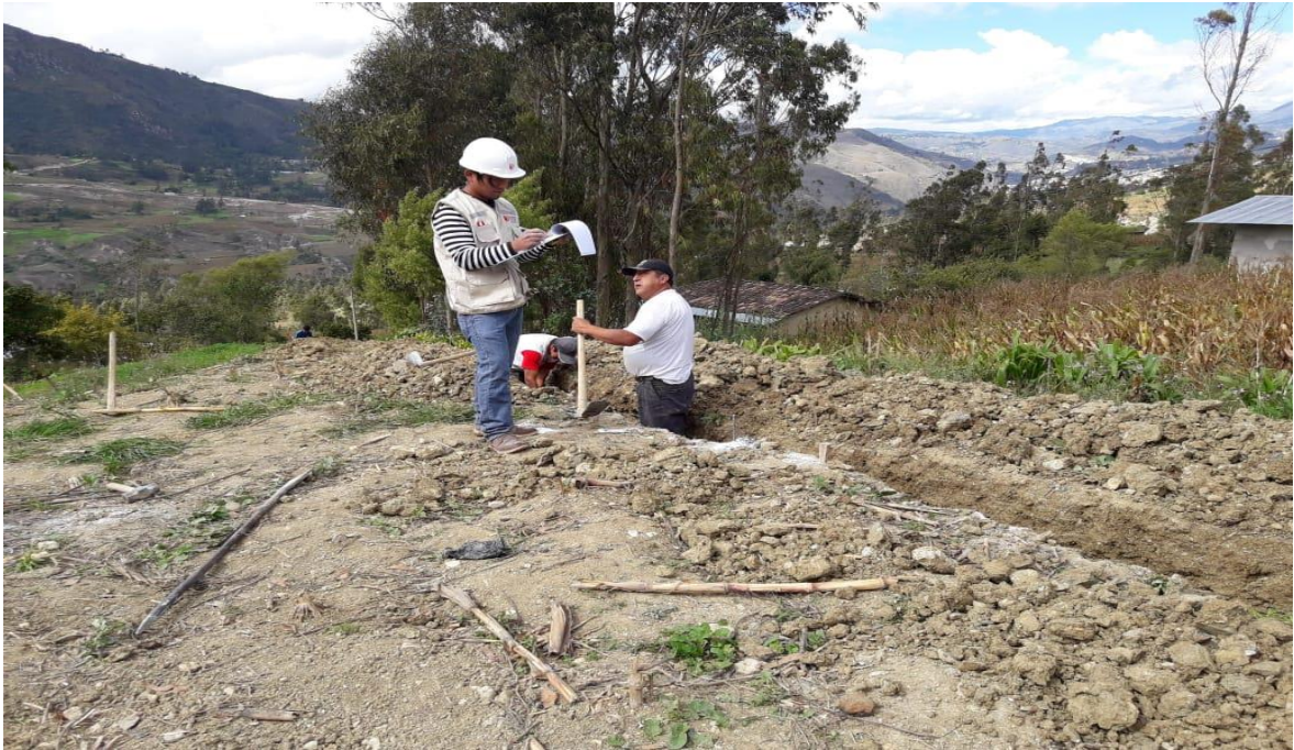
Ilustración 28. Excavación de zanja línea 1.
