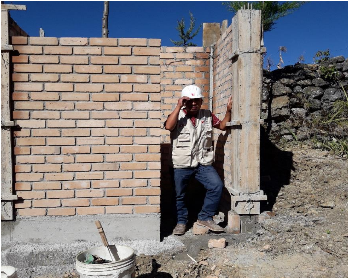
Ilustración 52. Encofrado de columnas listo para vaciar.
