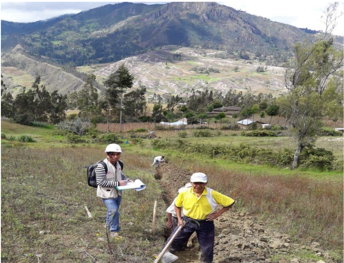
Ilustración 29. Excavación de zanja línea 2.
