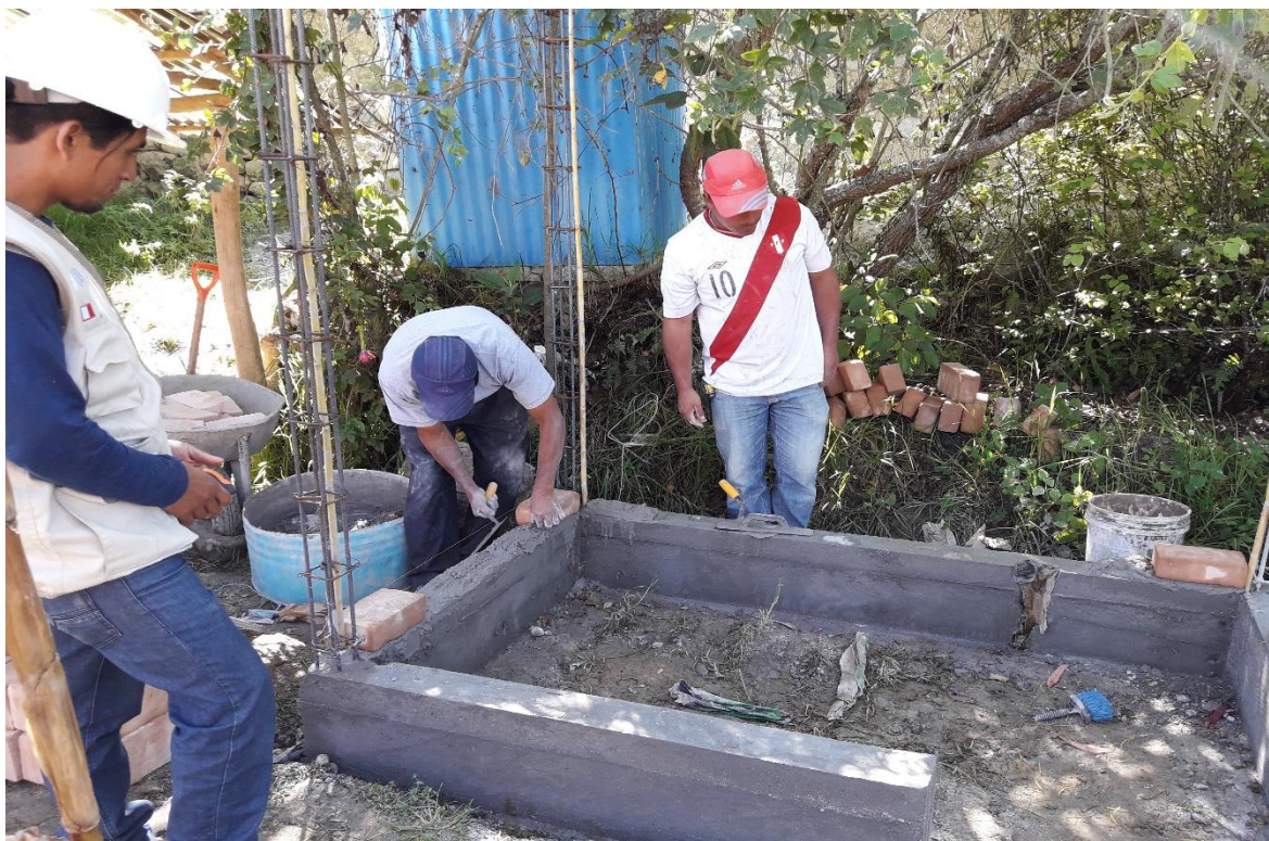
Ilustración 46. Inicio de asentado de ladrillo.
