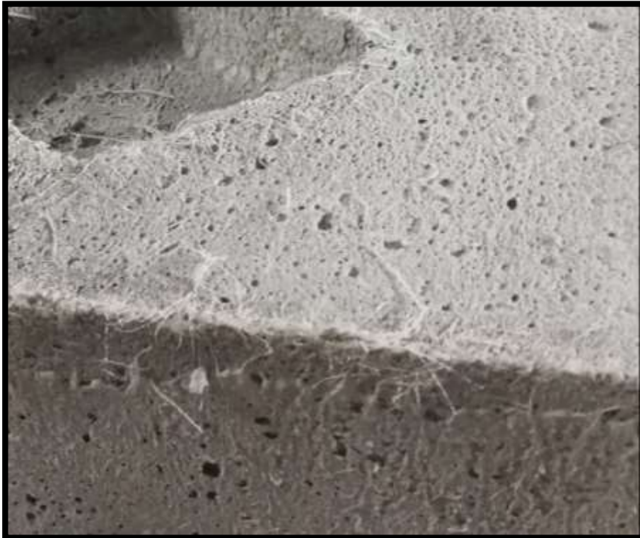
Imagen N° 26. Vacíos generados por la espuma en el concreto con fibra sintética.
