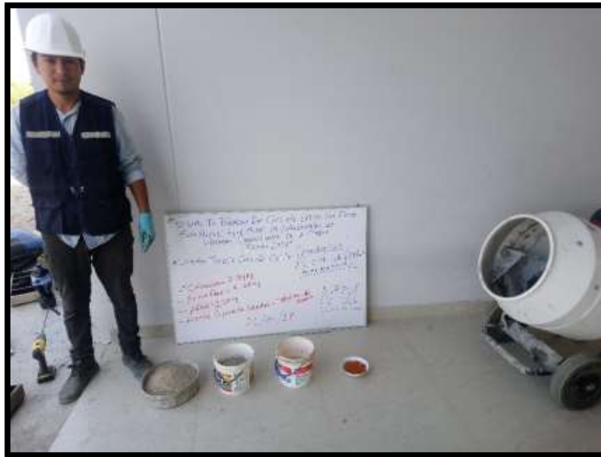
Imagen N° 15. Agregados pesados para la mezcla del concreto celular.
