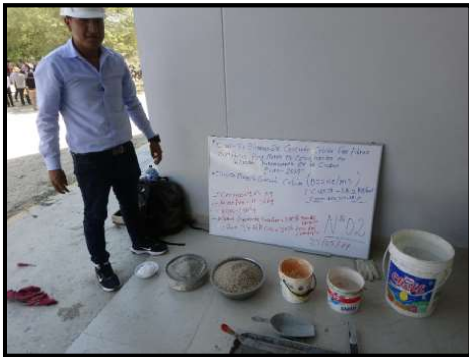
Imagen N° 18. Agregados para la mezcla de concreto celular con fibra sintética.
