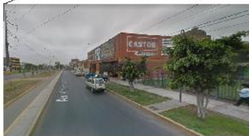
ESTABLECIMIENTO DE VENTAS DE MADERAS CASTOR EN LA AV. UNIVERSITARIA
