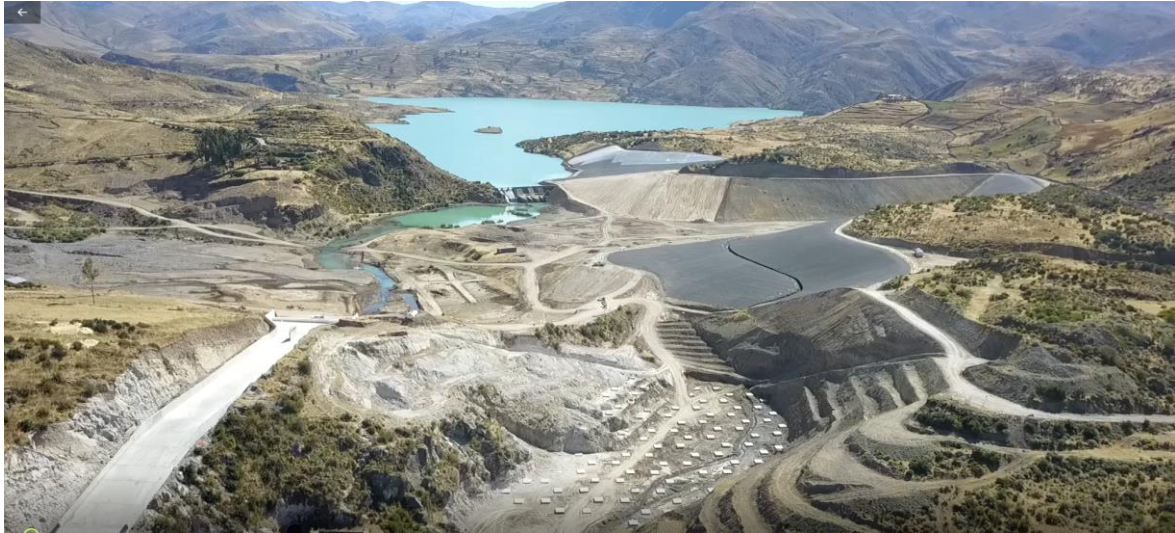
Figura 14. Otra vista Panorámica realizado con Drone, en la imagen se aprecia el aliviadero de demasías, movimiento de tierras y consolidación de cimentación de la presa proyectada, vaso de la presa zonificado en más de 6 partes por el tipo de tratamiento y la presa antigua.
