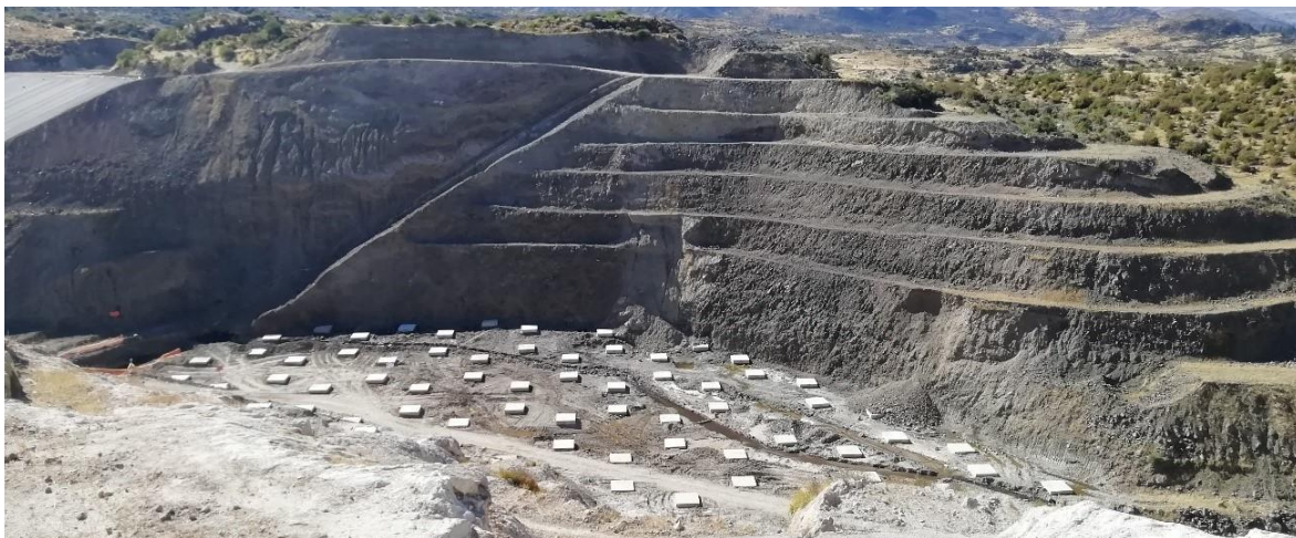
Figura 13. Vista concentrada de la zona donde se deberá realizar el relleno del cuerpo de la presa, se puede observar que actualmente se encuentra a nivel de cimentación, la misma que se realizó una consolidación con 93 pilotes de 12 metros de profundidad.
