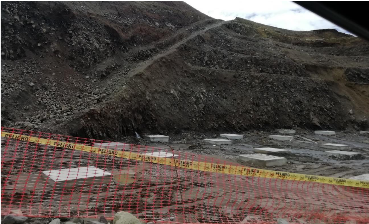
Figura 20. Filtración del estribo izquierdo de la presa en épocas de lluvia
