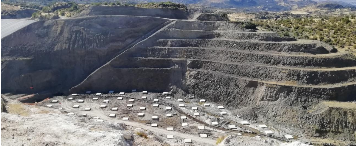
Figura 3. Vista de la zona de estudio, margen izquierda: terreno fracturado de color oscuro; margen derecha: terreno consolidado de color blanco; fondo vista de los pilotes ya ejecutados y zona de cimentación.
