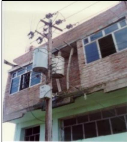
Figura 15. Poste de alumbrado muy cerca de la edificación.
