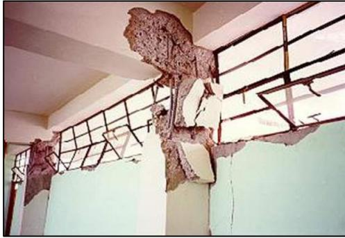
Figura 19. Falla por columna corta.
