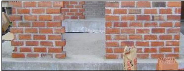
Figura 13. Parapeto sin confinar originaría desplome de muro.
