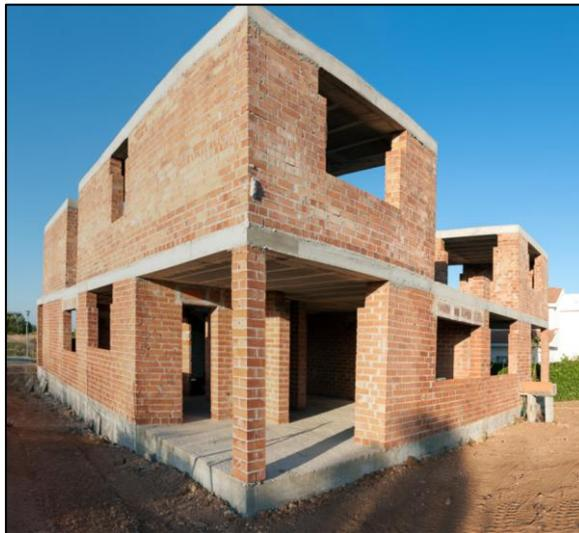
Figura 18. Edificación con muros sin confinar.
