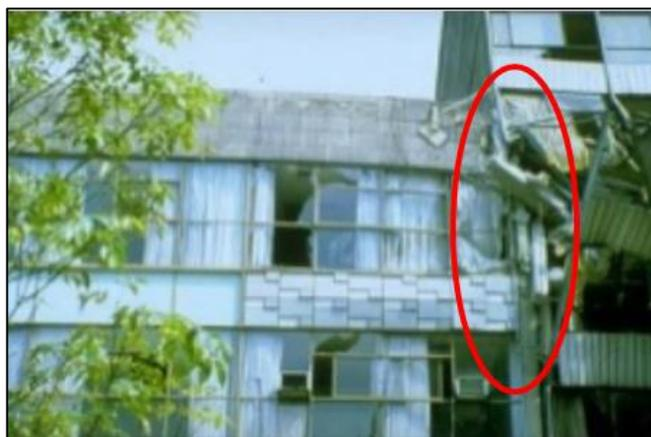
Figura 16. Edificios sin junta sísmica.
