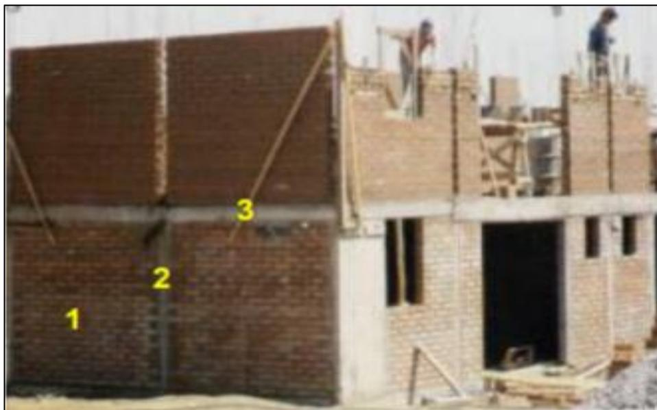
Figura 6. Secuencia de la construcción de la albañilería confinada.
