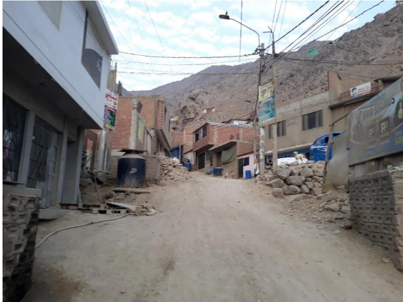
Foto N° 03 Vista Eje N° 1
