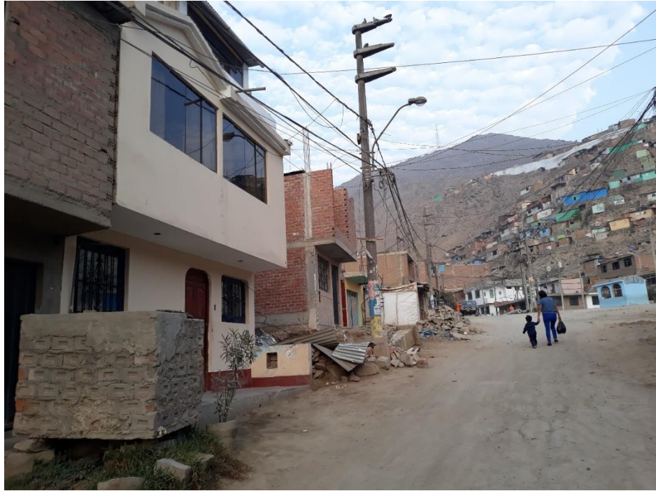
Foto N°01 Vista Eje N° 1
