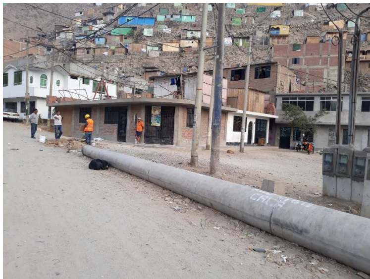
Foto N°04 Vista Eje N° 2
