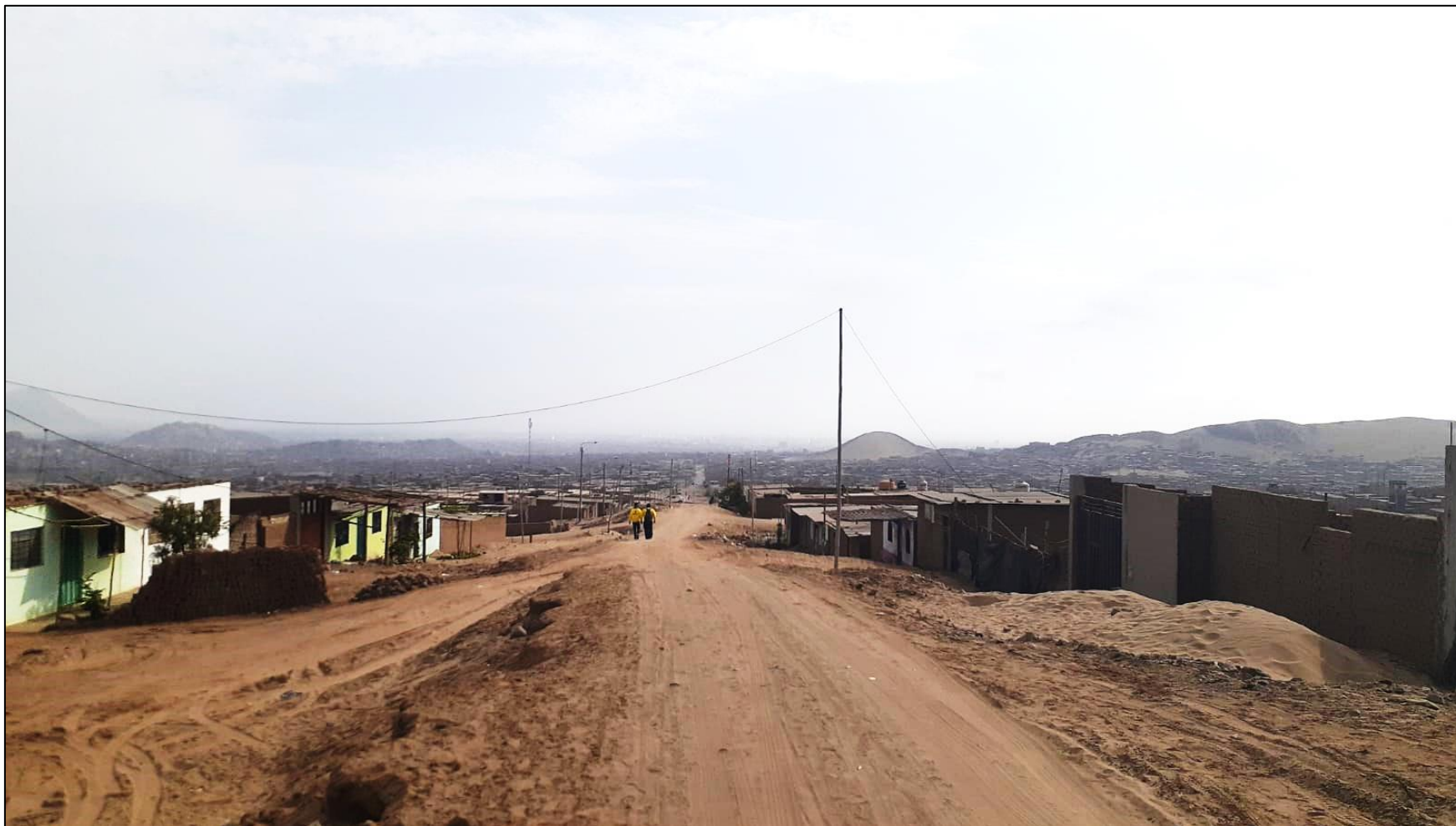
Avenida principal del barrio 6D del Centro Poblado Alto. (no cuentan con áreas verdes ni pavimentación)
