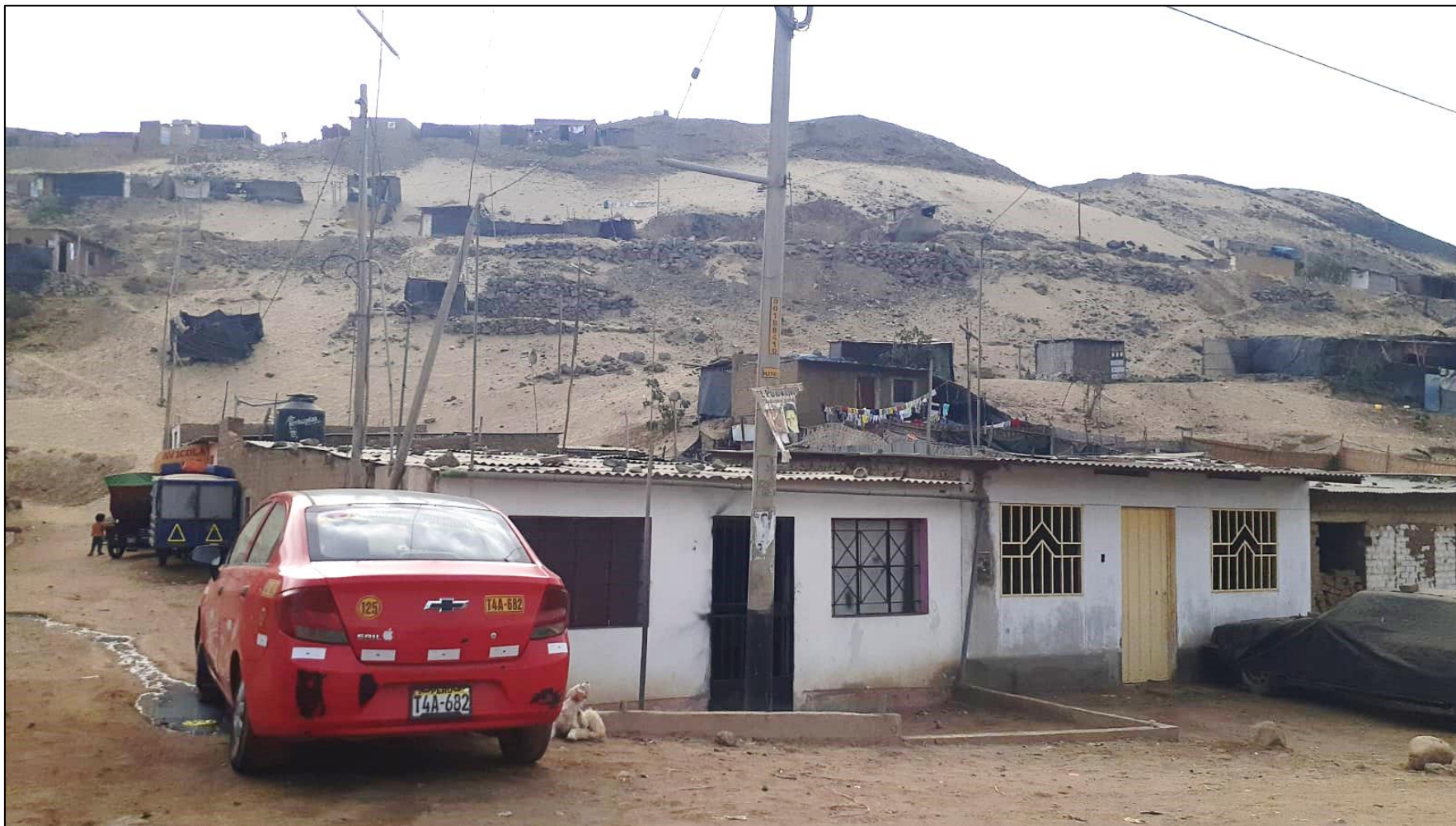
Fotografía tomada en el barrio 3B centro poblado Alto Trujillo, se evidencia la existencia de pozos ciegos o letrinas (pequeños ranchos negros)
