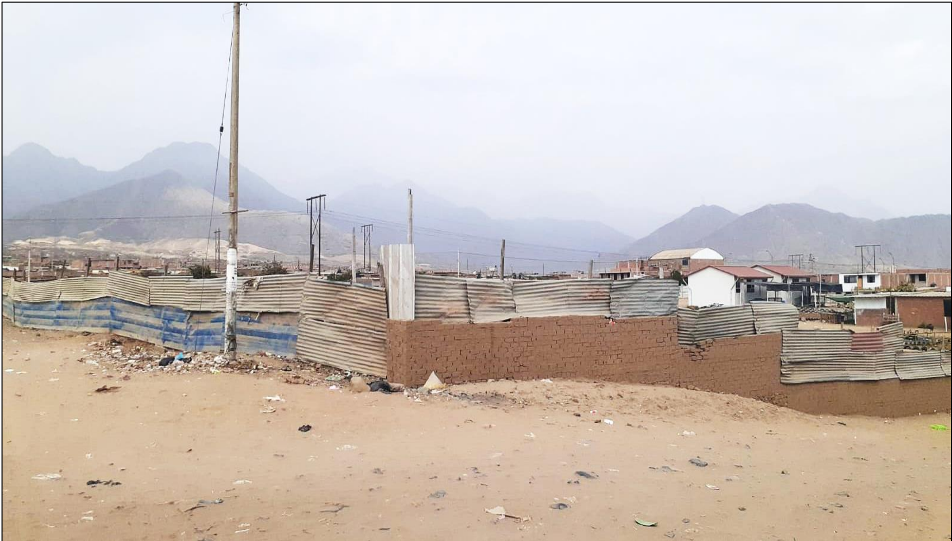
Cerco perimétrico de la Institución Educativa Barrio 6A del Centro Poblado Alto Trujillo
