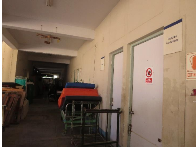
Figura 4: Camino para el área de mantenimiento del hospital.
