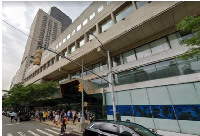
- Revestimiento de mármol travertino - Estructura de concreto
