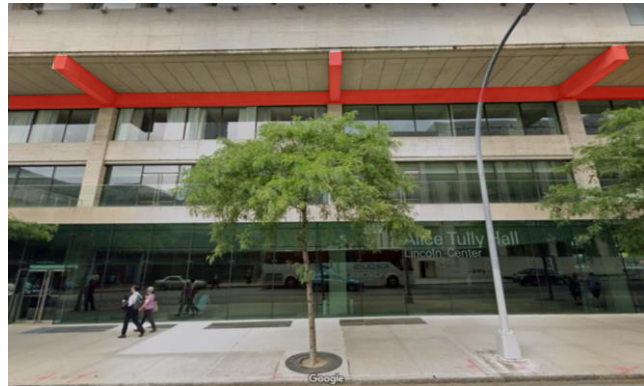
- Estructura original hecha con sistema aporticado de losas de concreto macizo y acero
