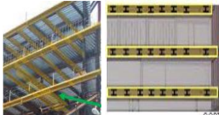
- La ampliación esta hecha con una estructura metálica de vigas metálicas en "H"
