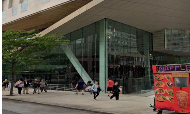
- Estructura de concreto - Cristal: a lo largo de dos y tres niveles de la fachada
