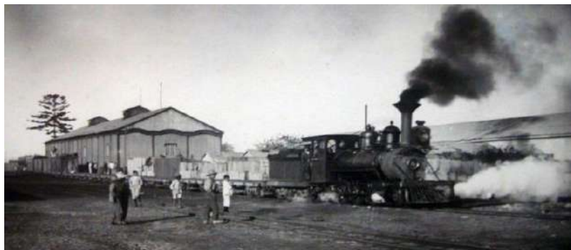
Imagen 02. La línea férrea Chimbote-Huallanca
