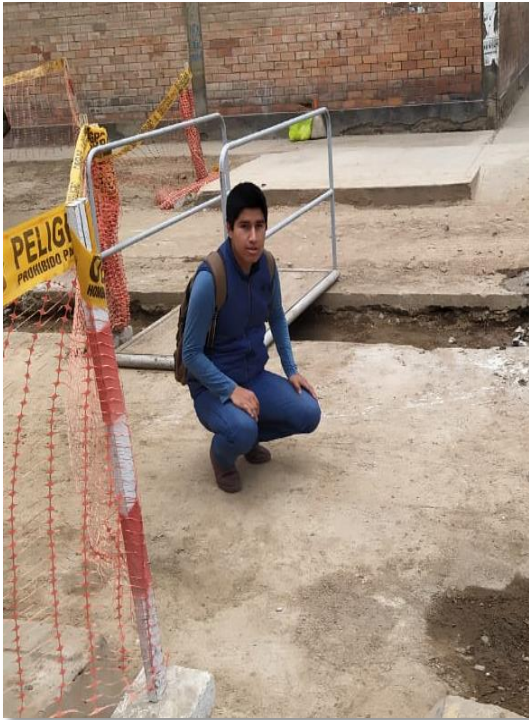
Figura 2. Capa de concreto
