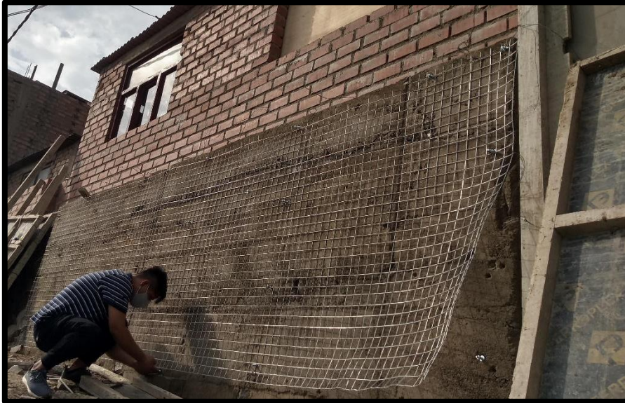
Figura N° 41: Anclaje de la malla electrosoldada en el muro de pirca
