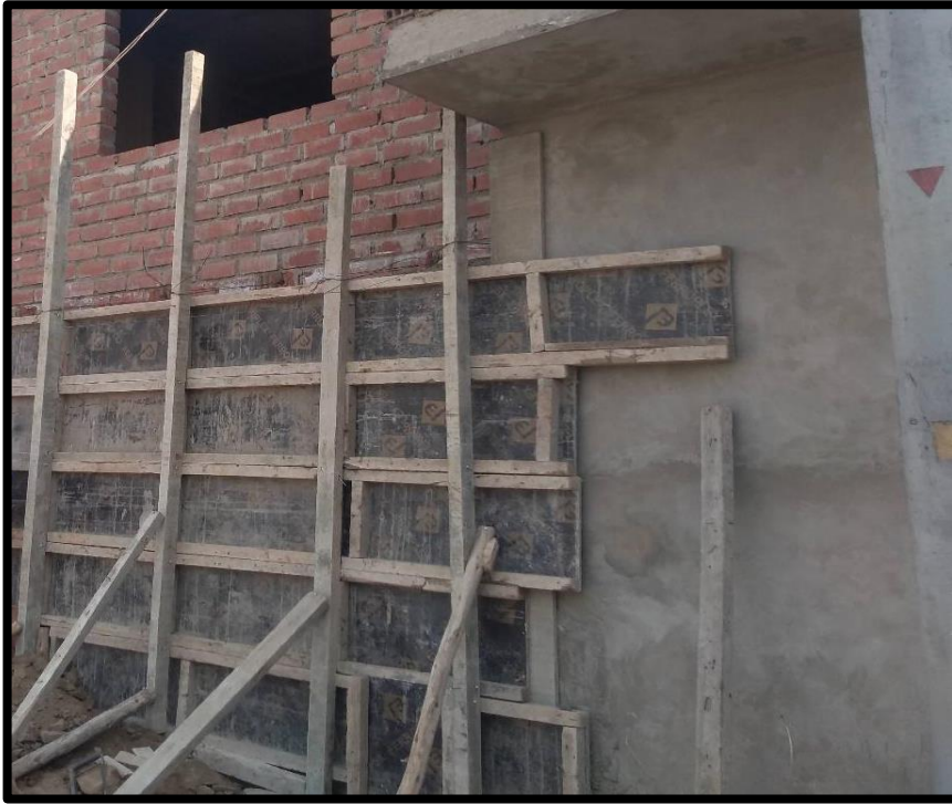
Figura N° 42: Encofrado del muro de pirca para el vaciado de concreto de 175 kg/cm 2
