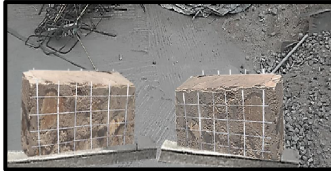
Figura N° 21: Fijación de la malla electro soldada en el murete de pirca
