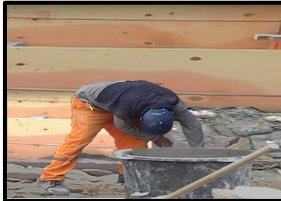
Figura N° 18: Asentado de piedras y mortero
