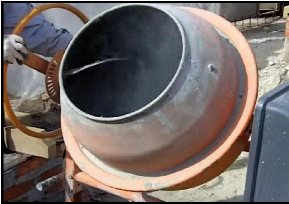
Figura N° 43: Preparación del concreto con una relación de 1: 2,5: 2,5
