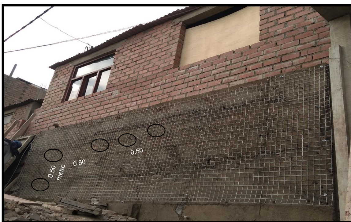
Figura N° 36: Muro de pirca perforado con pernos expansivos para permitir un anclaje fijo con la malla electro soldada
