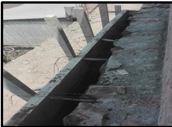
Figura N° 49: Verificación de la estabilidad del encofrado antes del vaciado
