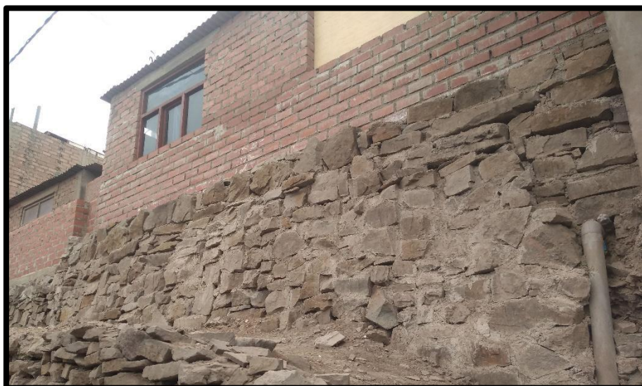
Figura N° 8: Muro de pirca construido por un maestro pirquero
