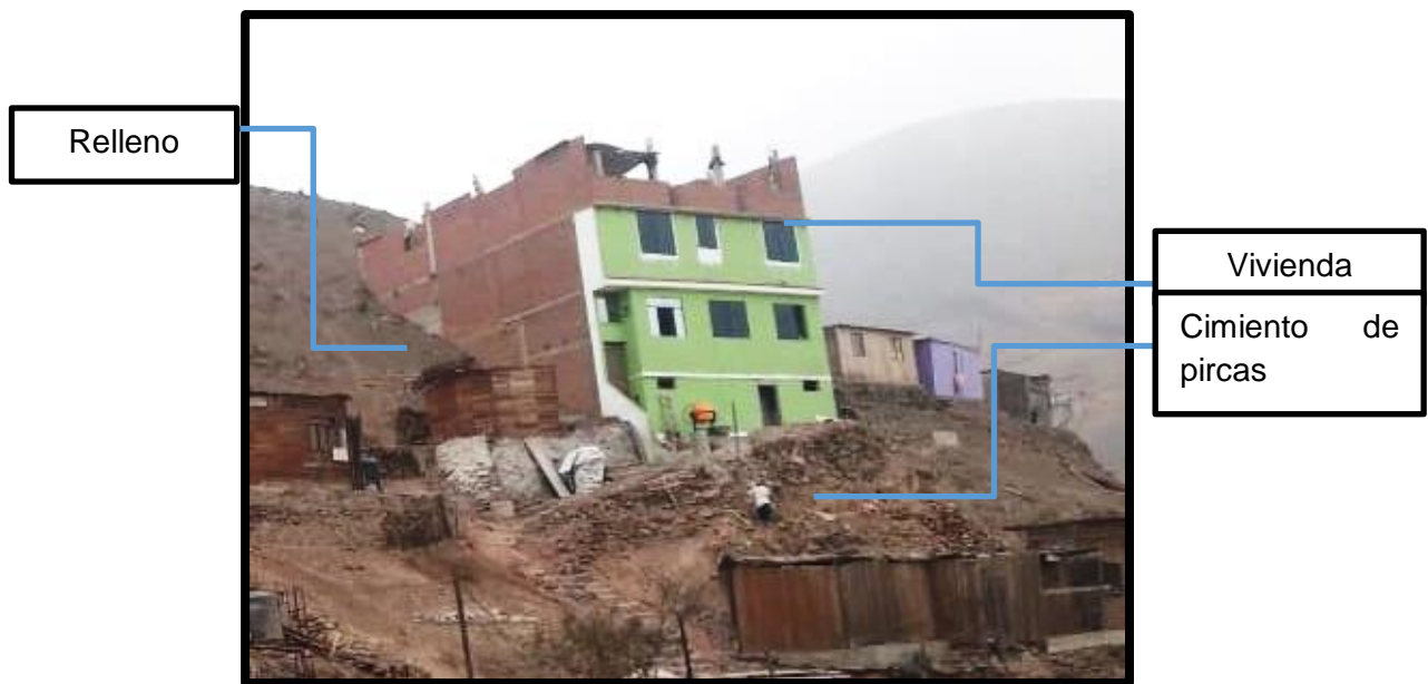
Figura N°1: Sistema del muro de pircas en viviendas de albañilería en el AAHH las Ánimas
