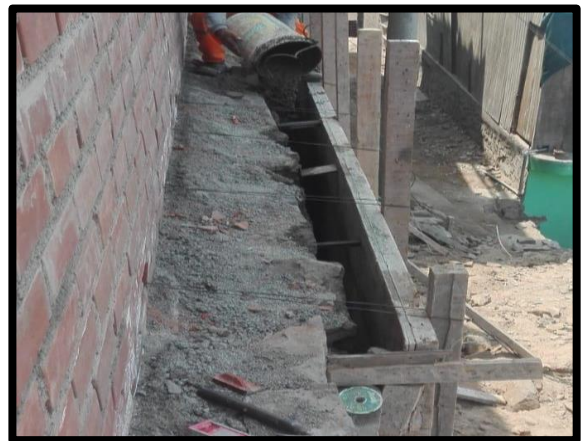
Figura N° 50: Vaciado del concreto en el muro encofrado
