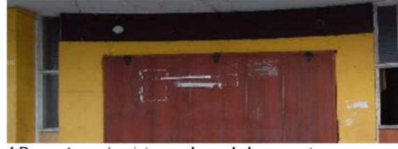
4. Desgaste en la pintura y humedad en puertas y vanos de ventana de madera; Destrucción de la cobertura de vidrio en la fachada principal del primer nivel.
