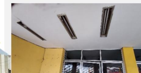
Las luminarias de la boletería están a la intemperie, posiblemente con daños o con los conectores oxidados por la filtración de la humedad en el ambiente.
