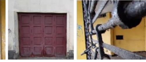
5. REJAS DE FIERRO CON ACABADO DE ESMALTE COLOR NEGRO EN PROCESO DE CORROSIÓN Y OXIDACIÓN DE
