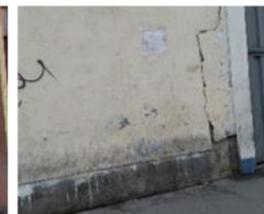
2. PAREDES CON SALITRE Y HUMEDAD (HONGOS) agrietamiento y desintegración del concreto
