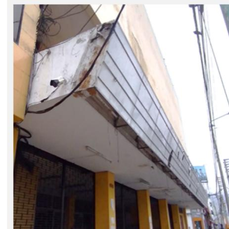
La actual luminaria exterior se encuentra totalmente deteriorada y desmantelada propio de la erosión del sol y el desgaste de los años.
