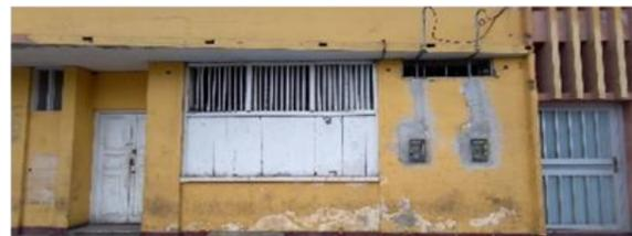
1. DETERIORO Y DESPRENDIMIENTO DE LA PINTURA en muros y puertas
