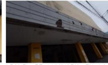
6. PANEL DE LUMINARIA EN LA FACHADA CON DESPRENDIMIENTO DE LA SUPERFICIE.
