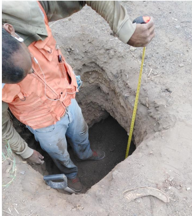
Figura 6.9: Excavación de Calicata 2 profundidad 1.50 m de carretera Trujillo – Laredo.
