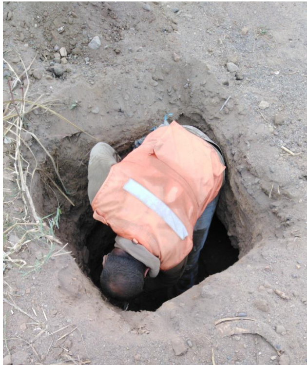
Figura 6.8: Excavación de Calicata 1 de carretera Trujillo – Laredo.
