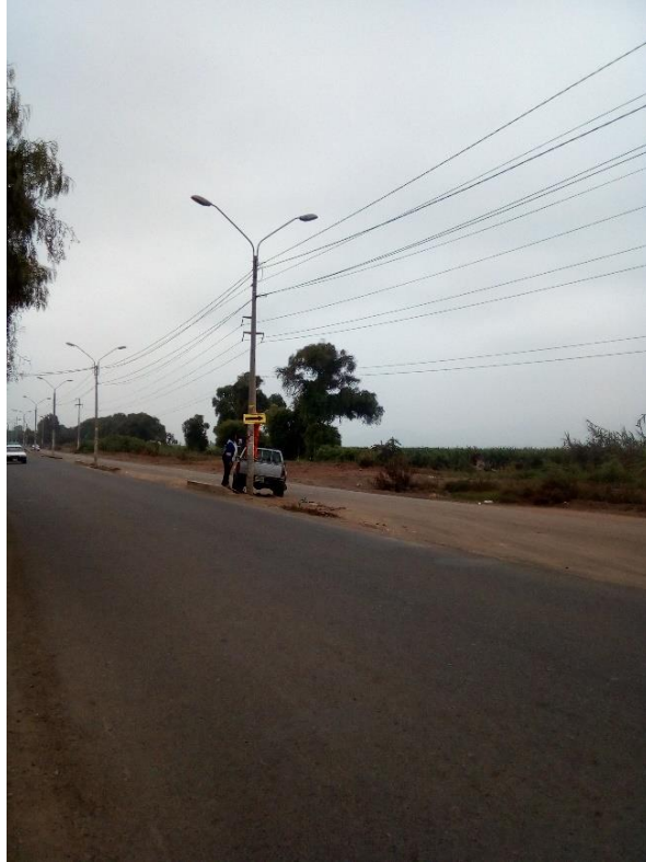
Figura 6.1: Estado Actual de la Doble Vía Trujillo - Laredo.
