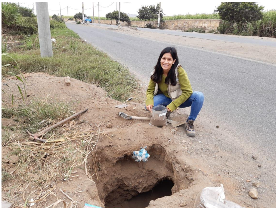
Figura 6.10: Extracción de muestra de Calicata 3 de carretera Trujillo – Laredo.
