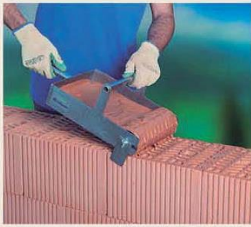
5 APLICACIÓN DE MORTERO
